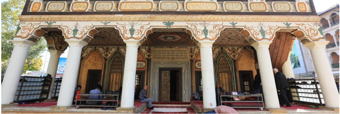
Resim 3. 11: Son cemaat mahalli giriş kuzey cephesi
