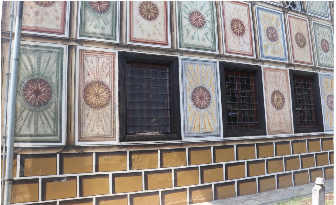
Resim 3.19: Kalkandelen Alaca Camii dış cephe duvar süslemeleri
