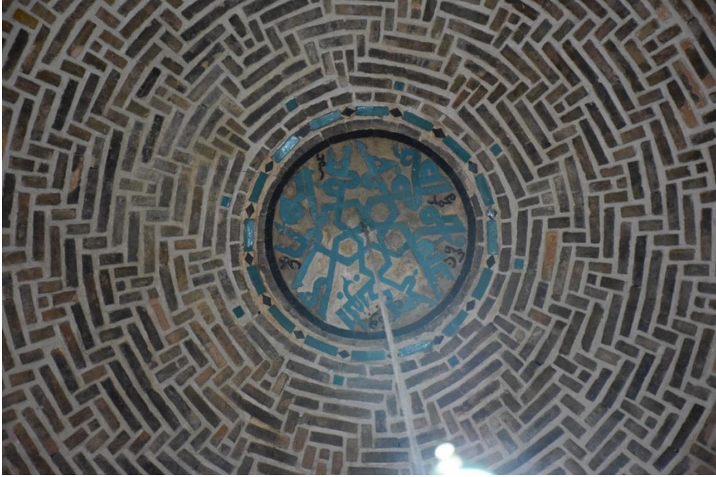
Şekil 2. Tahir ile Zühre Camisi'ndeki kubbe örgüsü ve kubbe merkezindeki çini pano
