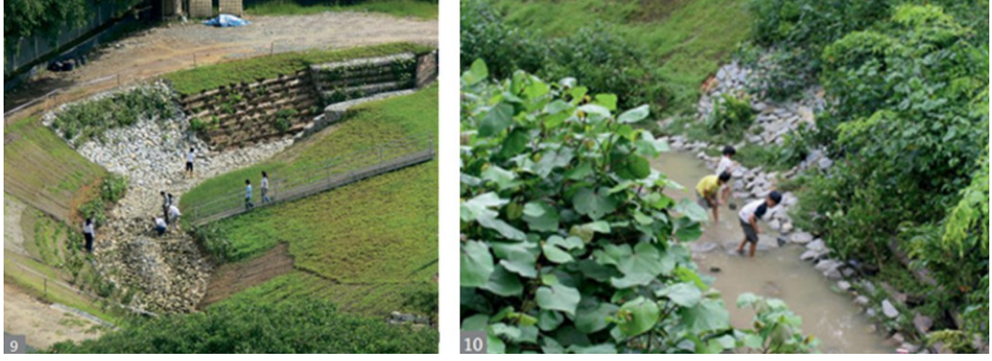
Şekil 5.30: Nehir kıyı stabilizasyonu uygulanan biyomühendislik teknikleri
