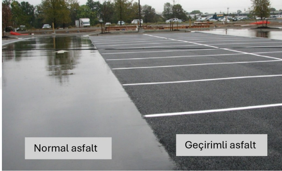
Şekil 4.23: Normal Asfalt ve Gözenekli Asfalt
