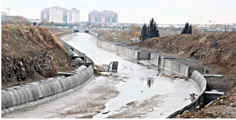
Şekil 6.22: Ayamama Deresi atıksu kolektörlerinin döşenmesi
