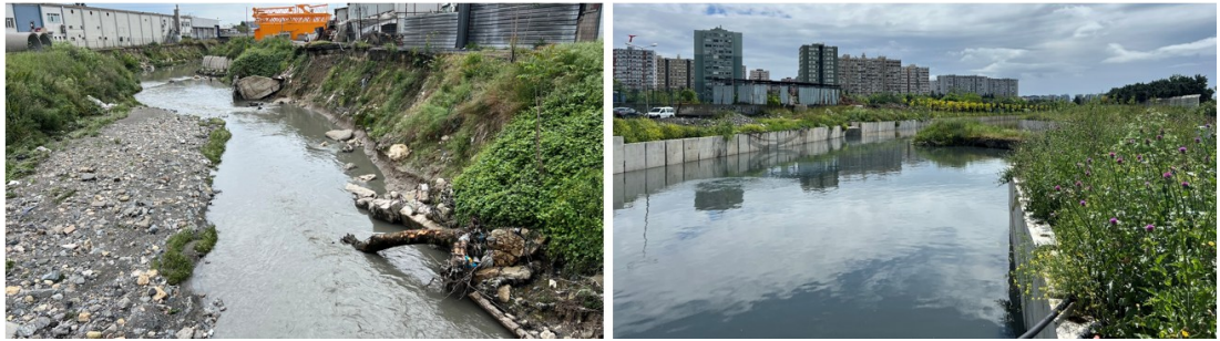
Şekil 6.42: Prekast kesit tamamlanmamış kısım, Ataköy bölgesi kanal
