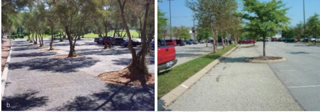
Şekil 4.24: Gözenekli beton kaplama
