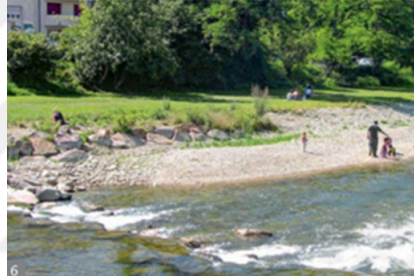
Şekil 5.18: Nehir tabanının rampalara dönüştürülmesi
