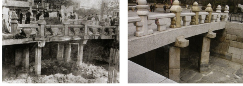
Şekil 5.97: The Gwangtonggyo köprüsü (1960) tekrar inşa edilen
