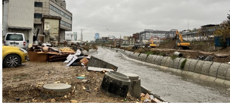
Şekil 6.19: Yapımı devam eden dere yatağı ve banka imalatı
