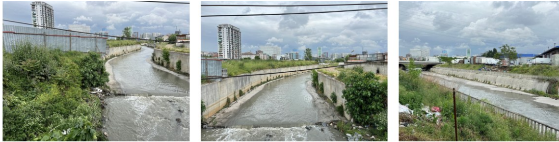
Şekil 6.40: Betonarme kanal içine alınmış dere
