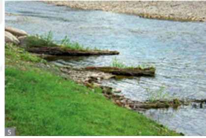
Şekil 5.20: Söğüt dalları ile yapılan biyomühendislik yöntem ile yönlendirme
