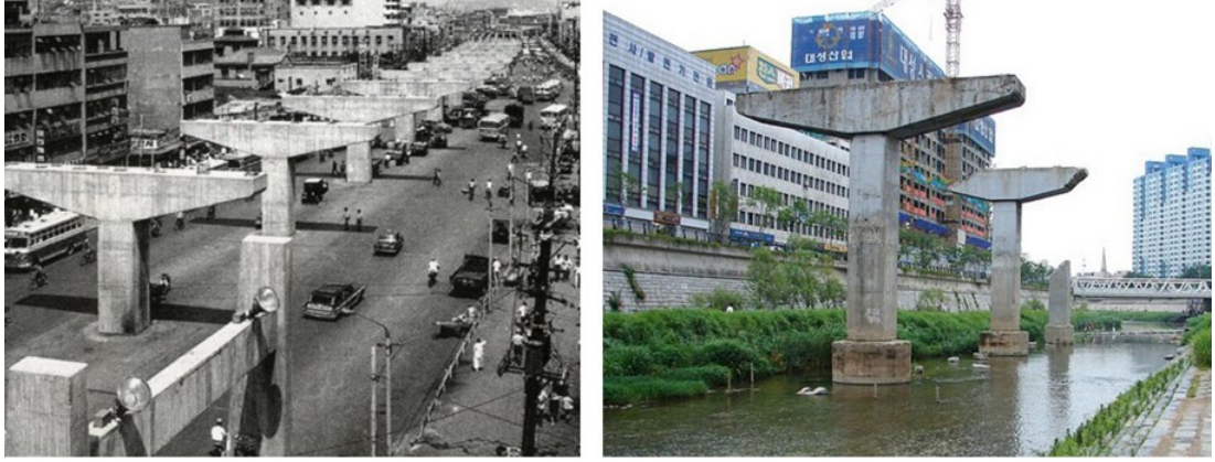
Şekil 5.90: Yükseltilmiş otoyolun kalıntıları
