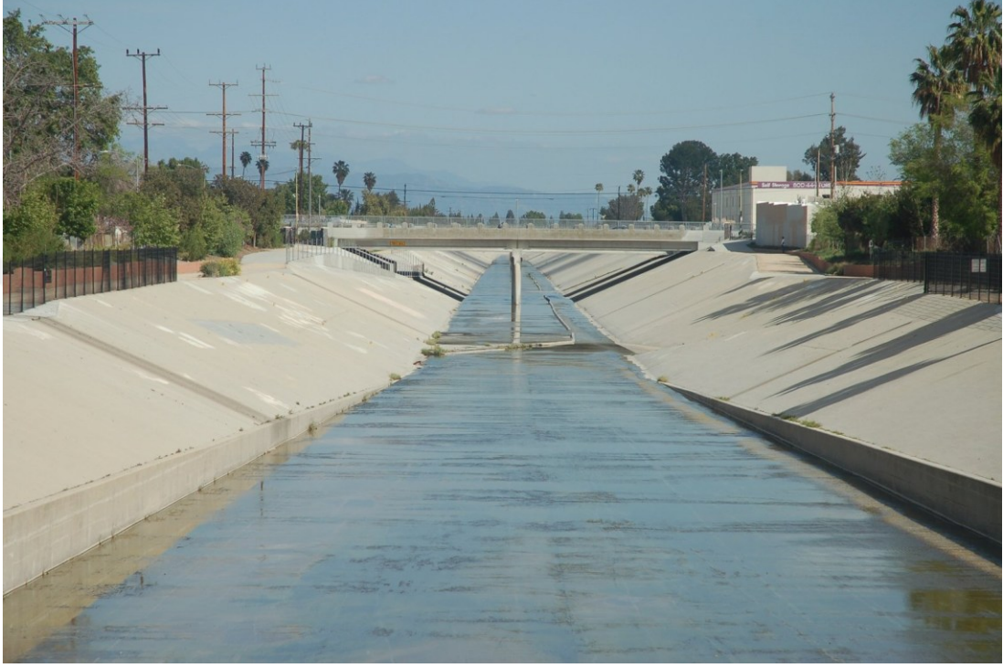
Şekil 3.36: Los Angeles Nehri Betonarme Kanal (11.10.2023)
