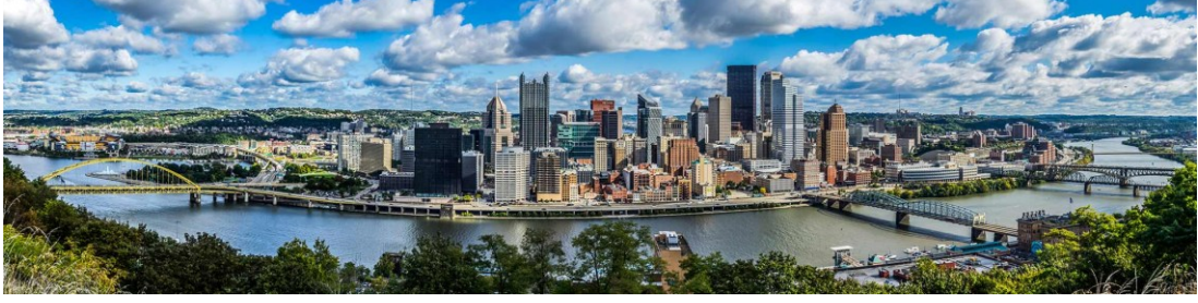
Şekil 3.45: Pittsburg Şehri görünüş (15.12.2023)
