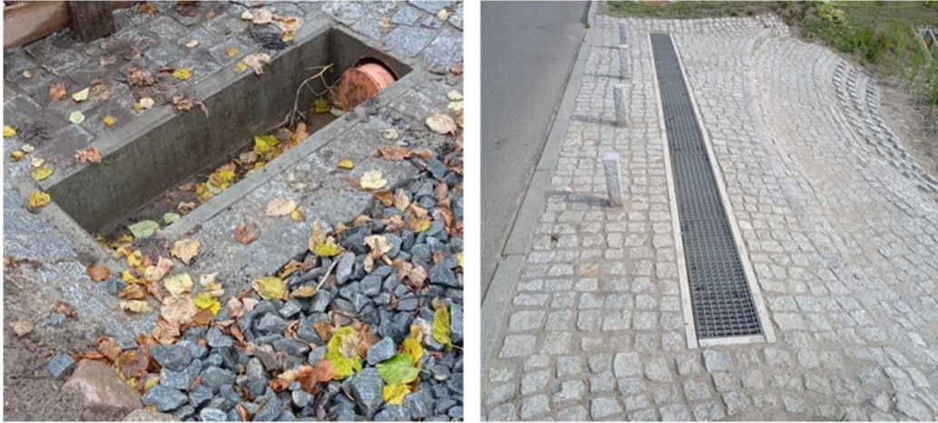
Şekil 4.14: Çökeltme tankı kurulum örnekleri
