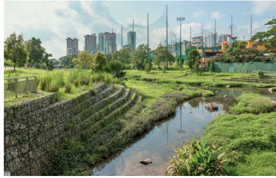
Şekil 5.31: Nehir kenarı gabyon uygulama
