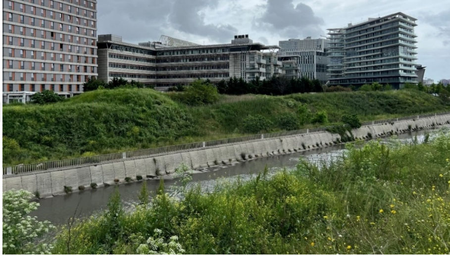
Şekil 6.88: Ayamama Deresi kenarlarında yer alan yeni yapılar
