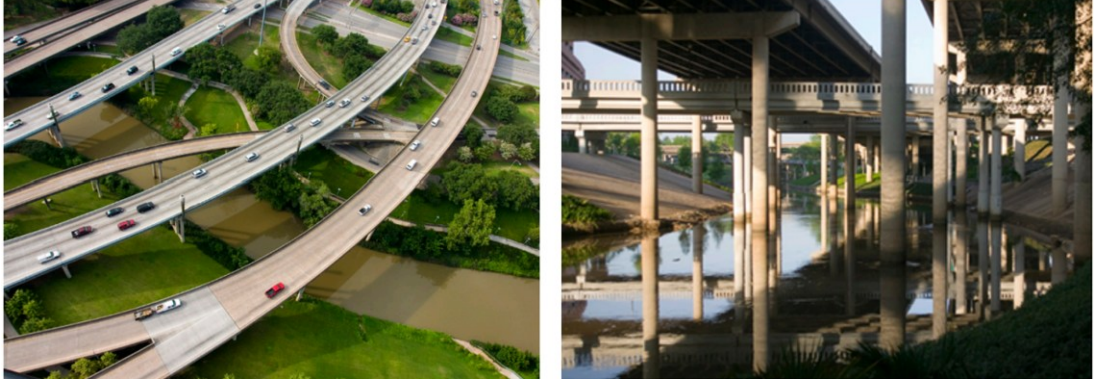
Şekil 5.105: Kavşak üst ve altından görünüş
