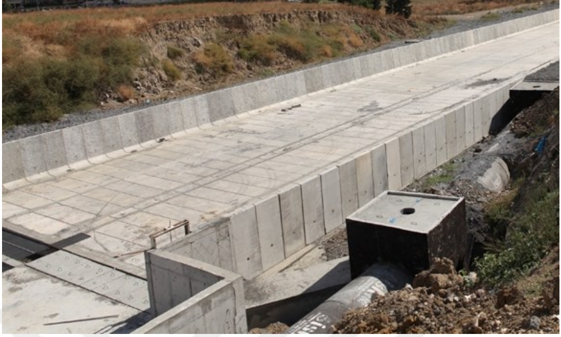
Şekil 3.25: Kağıthane Deresi betonarme kanal ile ıslah edilmesi. (15.11.2023)
