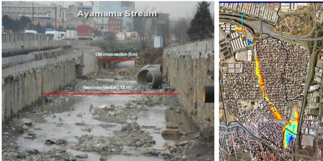
Şekil 6.7: Ayamama Dere'sinin dere yatağı kesitinin iyileştirilmesi ve İSKİ tarafından hazırlanan taşkın risk haritasının bir kısmı
