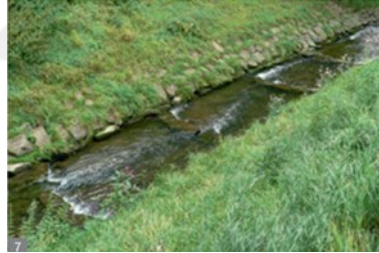
Şekil 5.12: Balık geçişleri için rampalar
