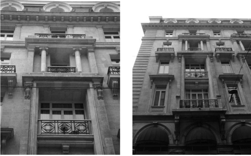
Resim 10. Pera Palas Giriş Cephesi Orta Kısım ve Aedicula Kısımı (Anıktar, 2012).
