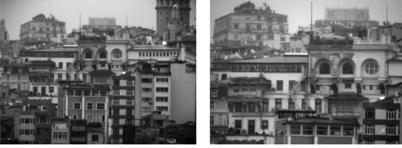
Resim 7. Osmanlı Bankası Güney Cephesi (Anıktar, 2012)
