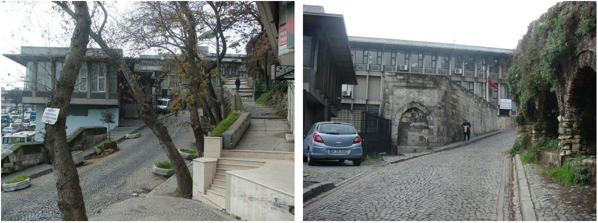
Resim 6. Yapı – Yol ilişkisi [9]
