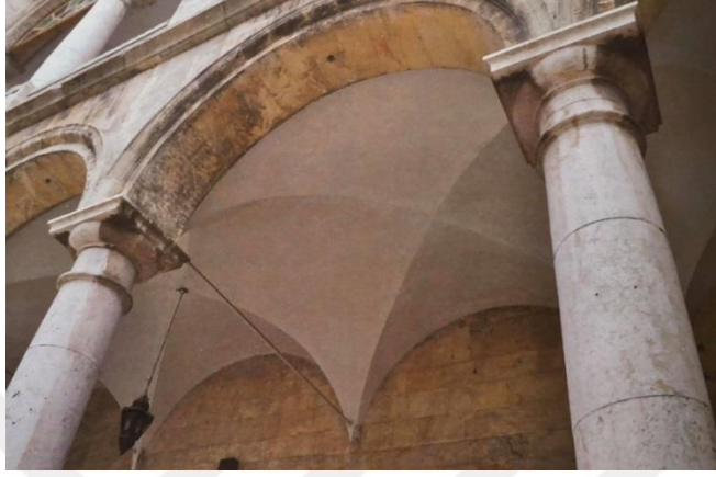
(Şekil 2.26).Şebani Medresesi(Gazi AntepÜniversitesi (2010).Halep'te AdımAdım Osmanlı'nın İzinde.S.382).
