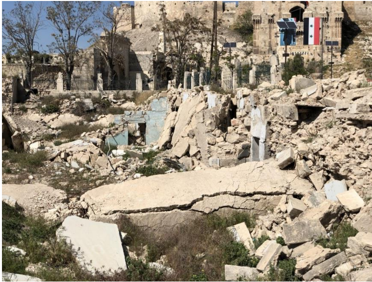
(Şekil 3.60): Husruviye Yıkılan Bölümleri(Nisan-2018).
