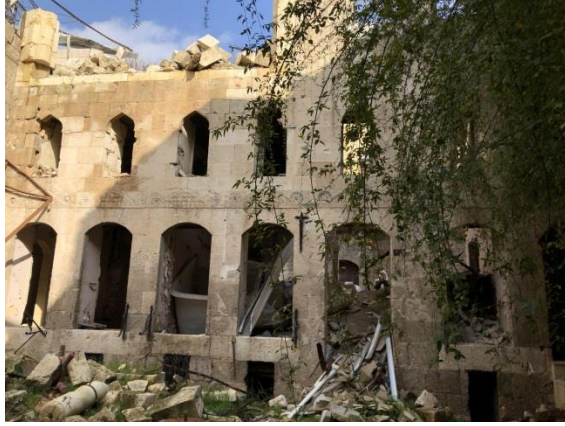
(Şekil 3.52):Vekil Evinde İç Cephesi(Ocak-2019).
