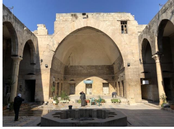
(Şekil 3.4): Firdevs Binanın Eyvanı (Ocak-2019).
