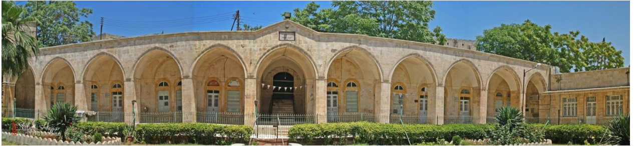
(Şekil 2.3):Hüsrüviye caminin Arka Duvarı ( Haccar S. ,2007).
