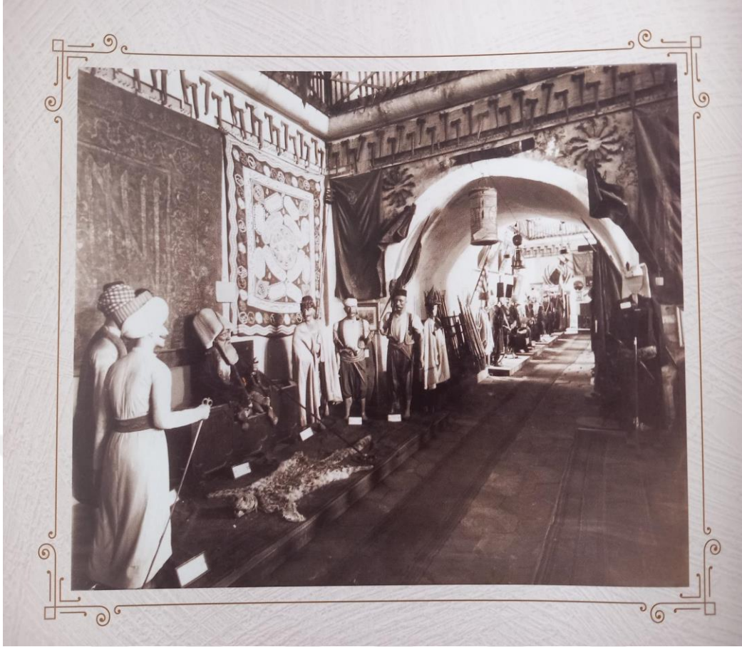
Şekil 2.14: Askeri Müze İçerisindeki Balmumu Heykeller, (1913).
