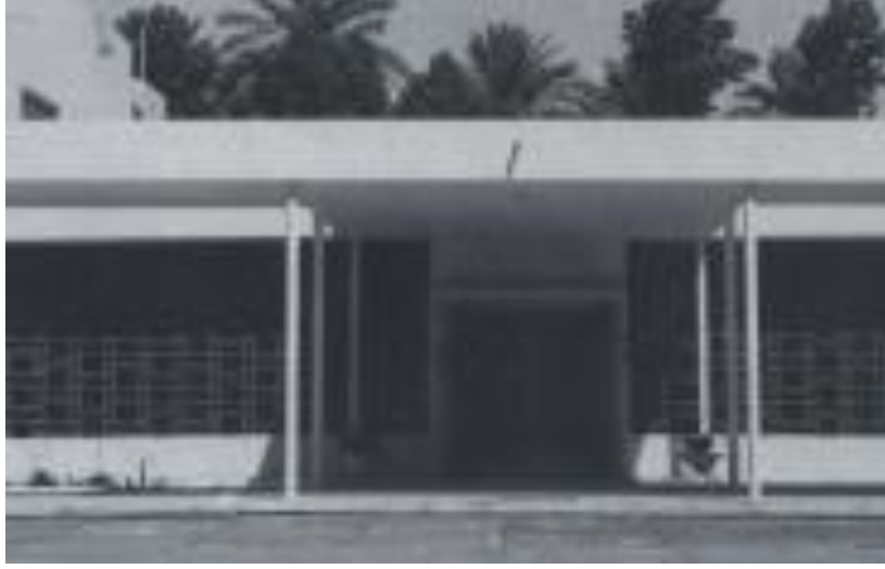
Şekil 1: Munzer Abbas Evi (Kaynak: (Arab Center for Architecture, 2025))
