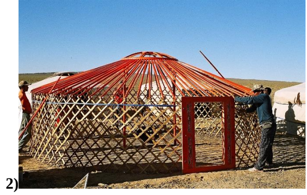
Şekil 1: Yurdu Meydana Getiren Unsurlar: a. kerege, b. kaplama, c. turdok, d. köşk, f. üzük, g. uk, h. başkur kolanı veya ipi, i. kolan veya ip, j. arkan, l. tümüldük (Diyarbakirli, 1972; Ögel,1984).
