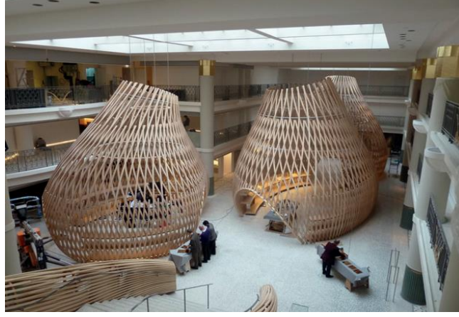
Şekil 8: Hermes, Rive Gauche, Paris – serbest biçimli ahşap ızgara kabuğu pavyonlarının uygulanmış şekli (Chilton ve Tang, 2016).
