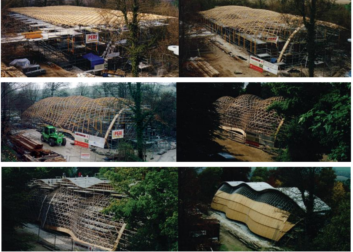
Şekil 11: Weald and Downland ızgara matının yerçekimi ile indirilmesiyle başlayan ızgara kabuğunun oluşturulma aşamaları (Chilton ve Tang, 2016).
