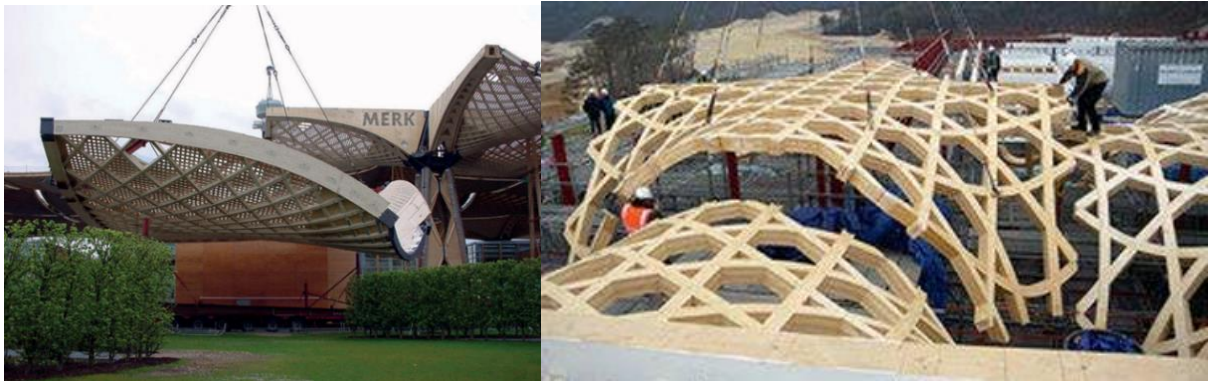
Şekil 17: Rijit ahşap kabukların montajını gösteren fotoğraflar (Chilton ve Tang, 2016).
