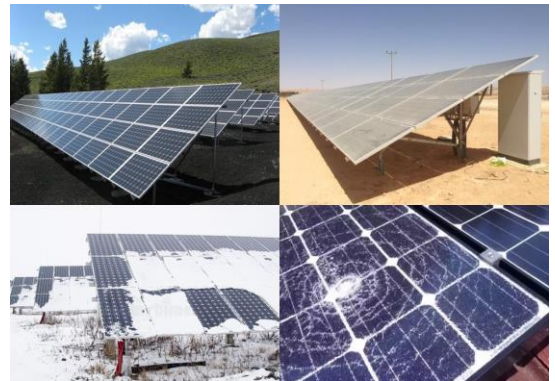
Fig. 1. Clean, Dirty, Damaged ve Snow-Covered sınıflarına ait güneş paneli örnekleri.
