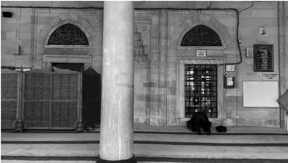
Şekil 4. 5: Lüleburgaz Sokullu Mehmed Paşa Camii Son Cemaat Yeri (Doğu Tarafı)
