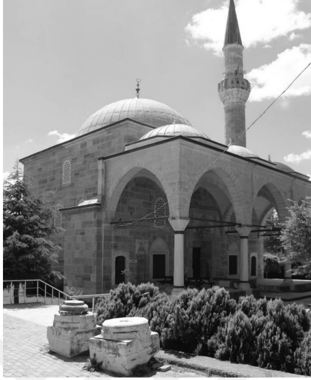
Şekil 2. 7: Havsa Sokullu Mehmed Paşa Camii
