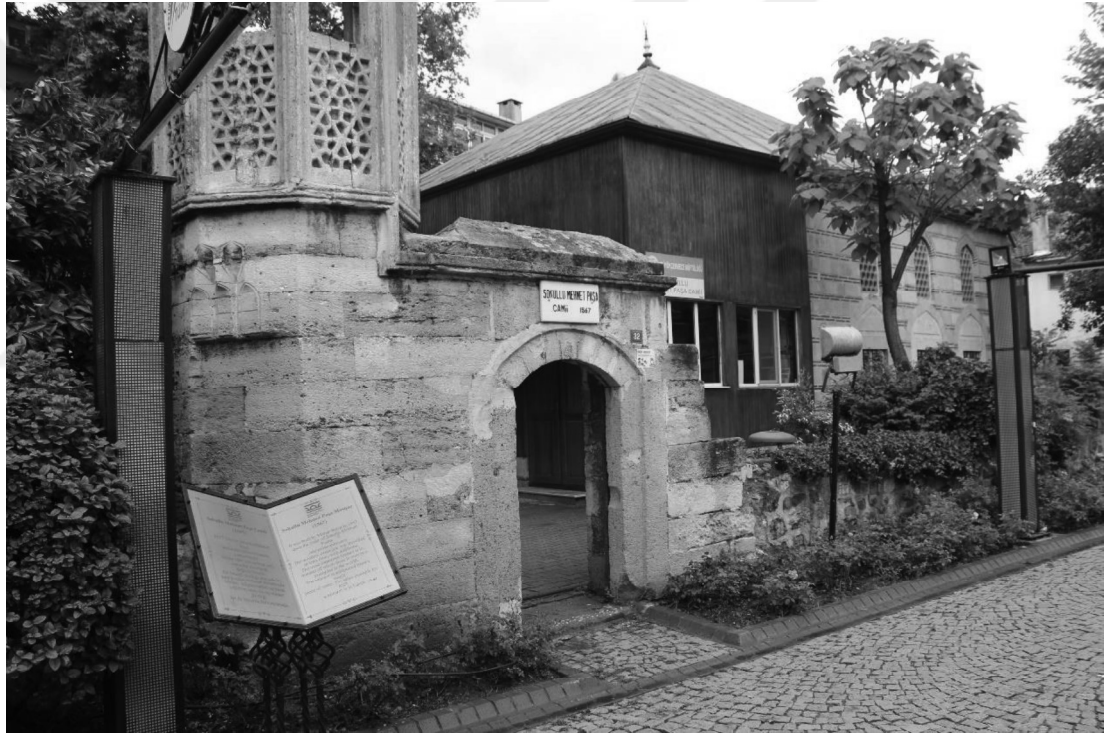
Şekil 2. 23: Büyükçekmece Sokullu Mehmed Paşa Külliyesi Batı Giriş Kapısı (Minare)
