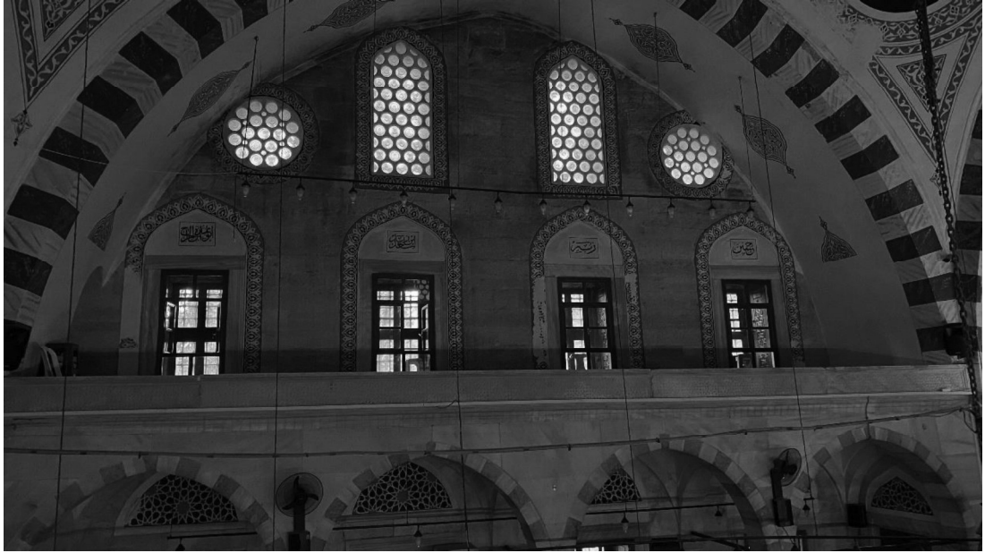
Şekil 4. 9: Lüleburgaz Sokullu Mehmed Paşa Camii Doğu Cephesi Duvarı
