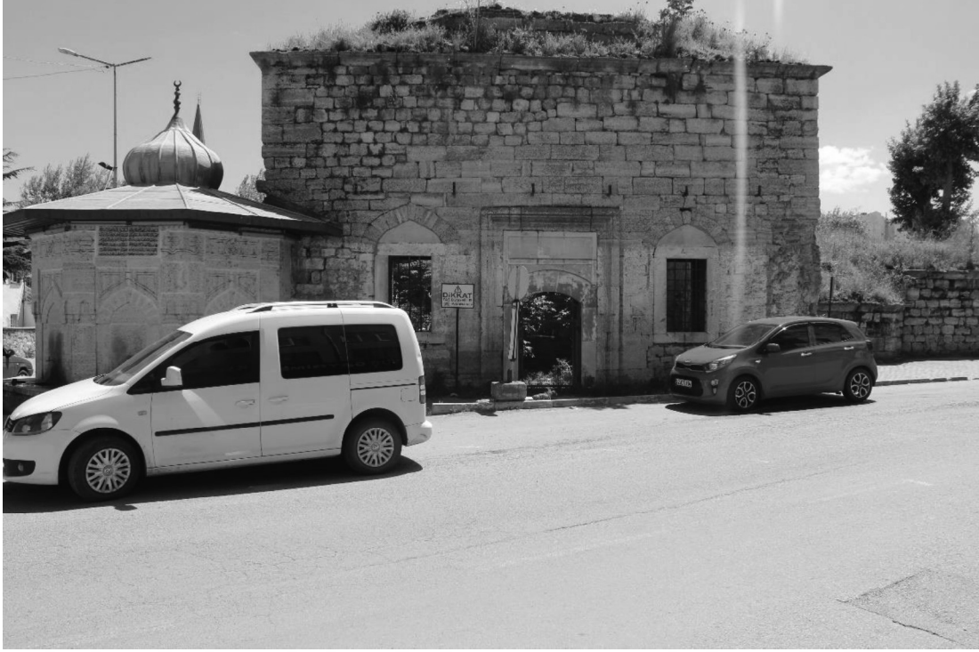
Şekil 2. 6: Havsa Sokullu Mehmed Paşa Külliyesi Hamamı ve Çeşmesi
