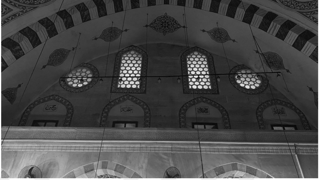
Şekil 4. 8: Lüleburgaz Sokullu Mehmed Paşa Camii Batı Cephesi Duvarı
