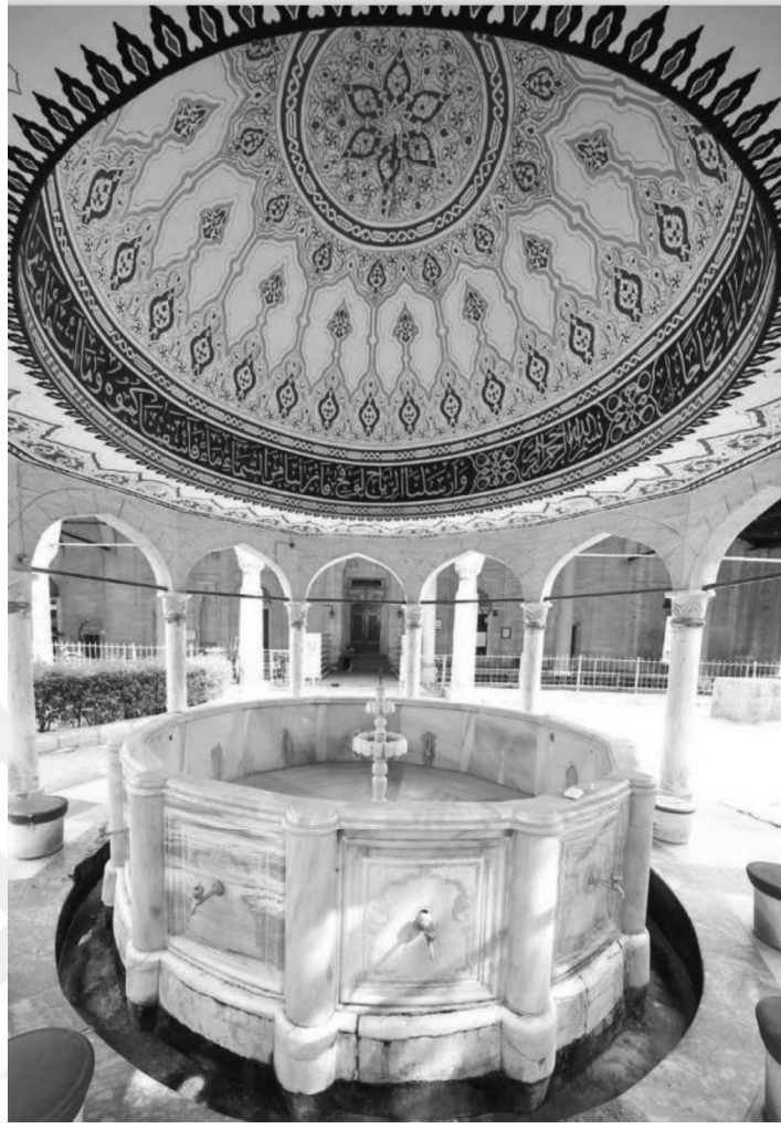
Şekil 2. 15: Babaeski Semiz Ali Paşa Camii Şadırvan Havuzu ve Kubbe Ayrıntısı
