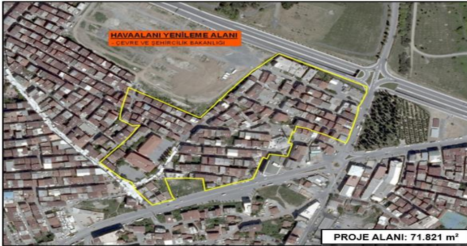
Şekil 3.2: Havaalanı Yenileme Alanı (Esenler Belediyesi Faaliyet Raporu'12, 2013: 84)
