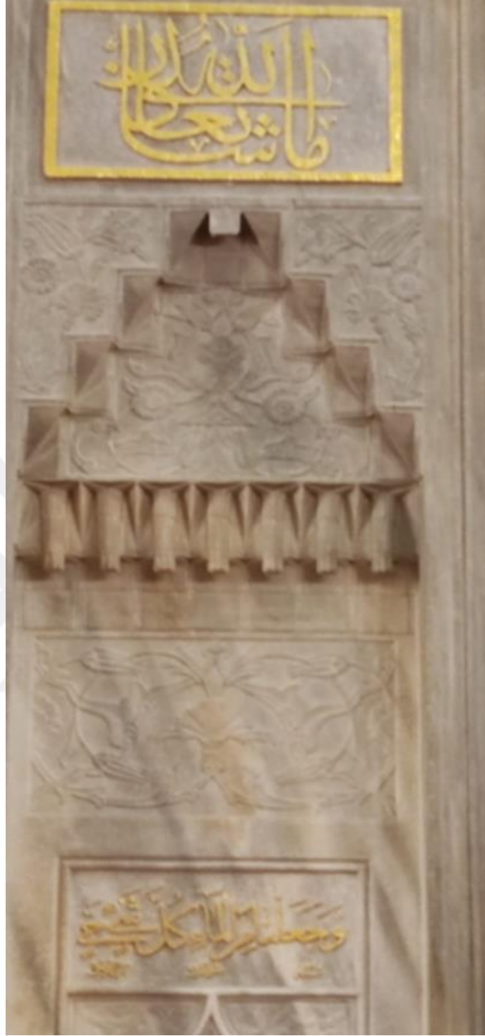
Resim 100. Sultan Ahmed Camii Paye Filayağı Yazısı 2
