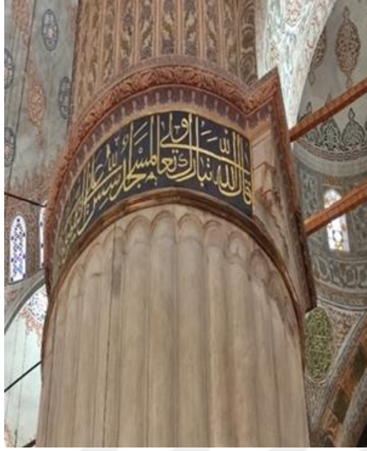
Resim 101. Sultan Ahmed Camii Paye Filayağı Yazısı 3
