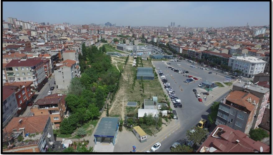
Fotoğraf 4.3: Bağcılar Kirazlı Transfer Merkezinin Mevcut Durumunun Güney Yönünden Drone Görüntüsü
