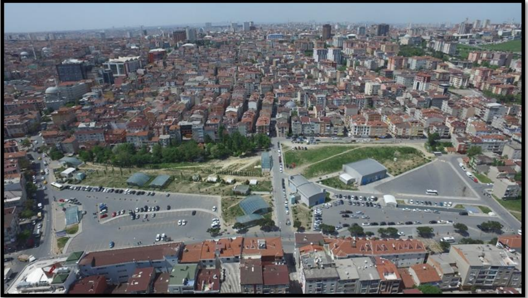
Fotoğraf 4.2: Bağcılar Kirazlı Transfer Merkezinin Mevcut Durumunun Doğu Yönünden Drone Görüntüsü
