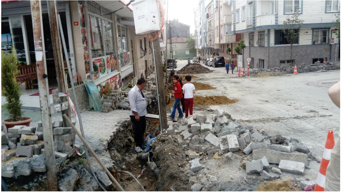
Şekil 4.12: Güvenlik Önlemi Alınmamış Altyapı Kazı Çalışması
