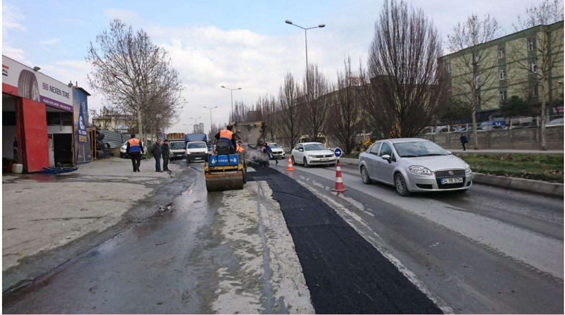
Şekil 4.14: Ana arter üzerinde yapılan asfaltlama çalışması
