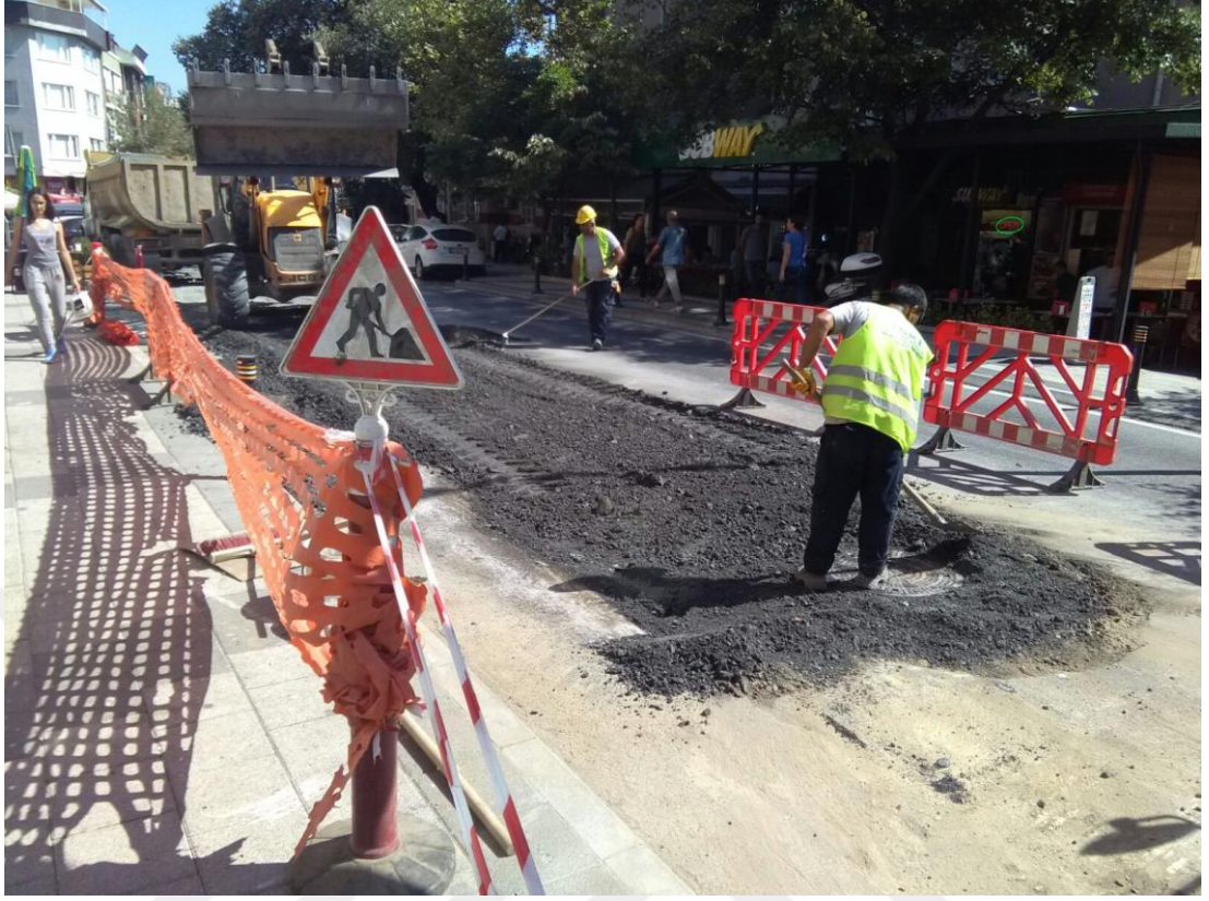
Şekil 4.15: Ana arter üzerinde yapılan asfalt yama çalışması
