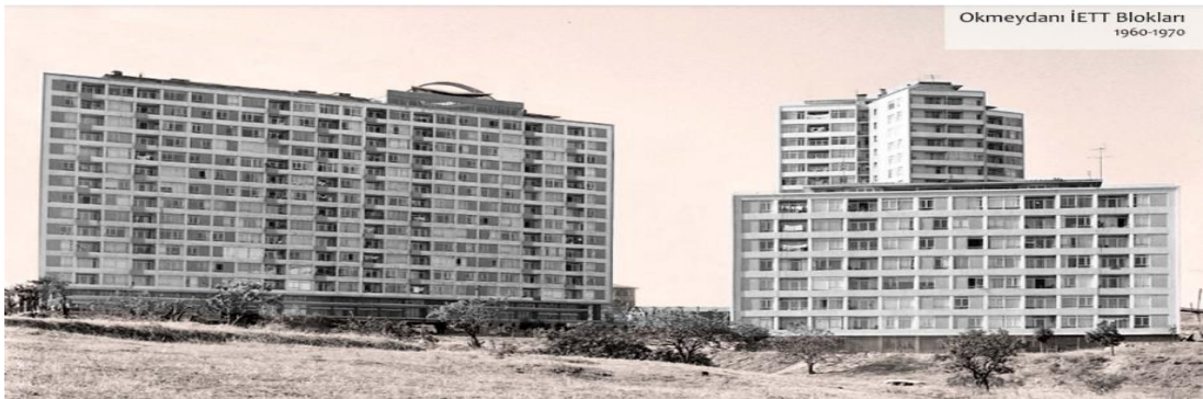
Resim 2.2: Kamu Apartmanları; Okmeydanı İETT Blokları, 1960.
