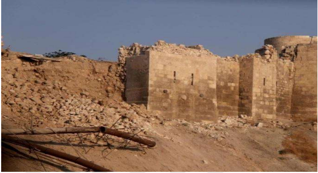
Şekil 4.3: 2015'te Rejim Güçlerinin Muhaliflerin Tünelini Havaya Uçurmasıyla Çöken Dış Duvar (2011)
