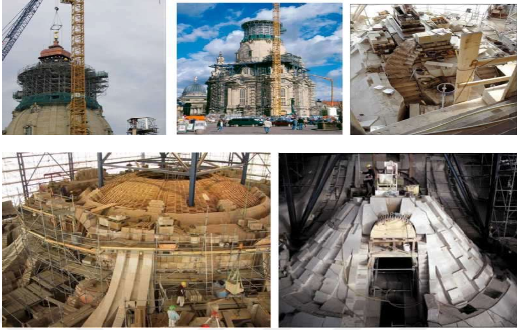
Şekil 5.13: Kilisenin Restorasyonu Kaynak: Jager Ingenieure GmbH, 2019
