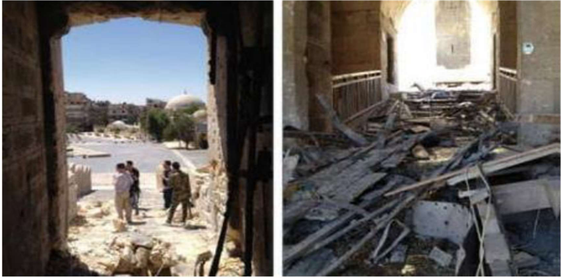
Şekil 4.4: Halep, Suriye Kale Girişinde Yıkım Görünümleri (2011)
