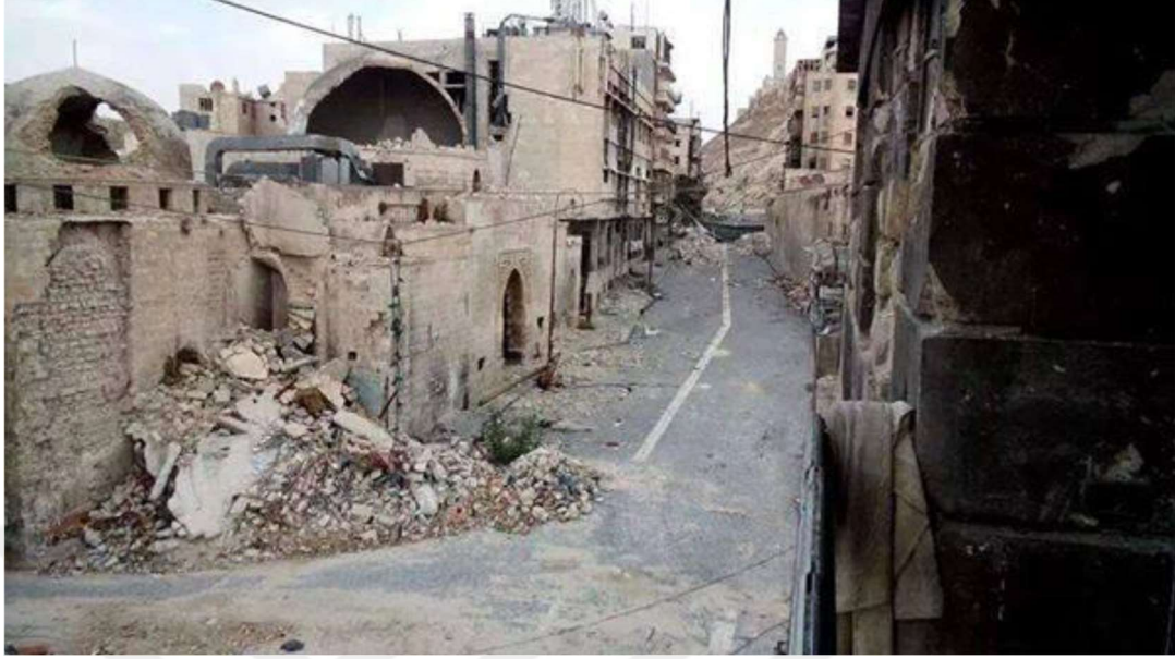
Şekil 4.21: Halep, Suriye Han El-Vezir’de Yıkım Görünüm (2012)
