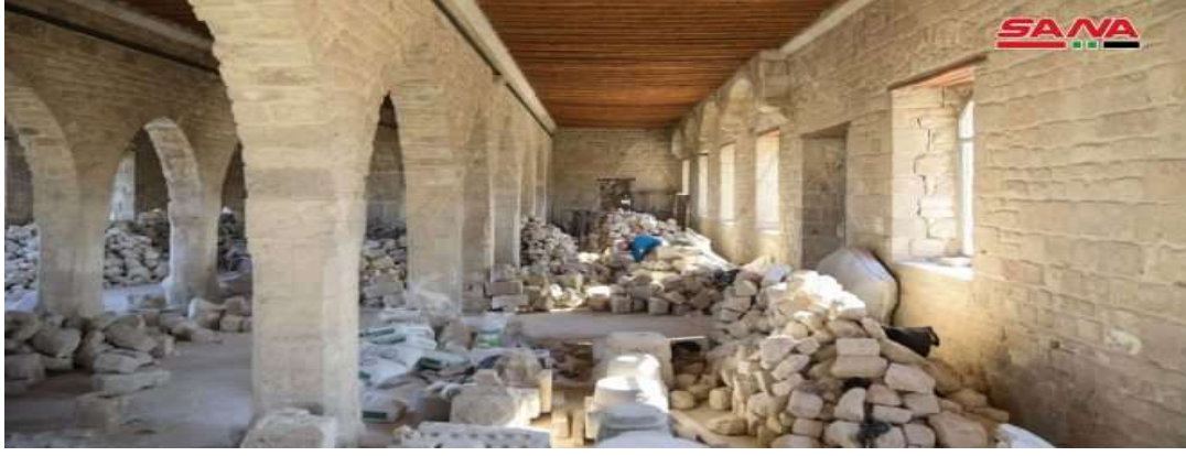
Şekil 6.1: Halep Kalesi'nin Bazı Bölümlerinin 13/11/2021 Tarihli Restorasyon Çalışmalarından Görüntüler
