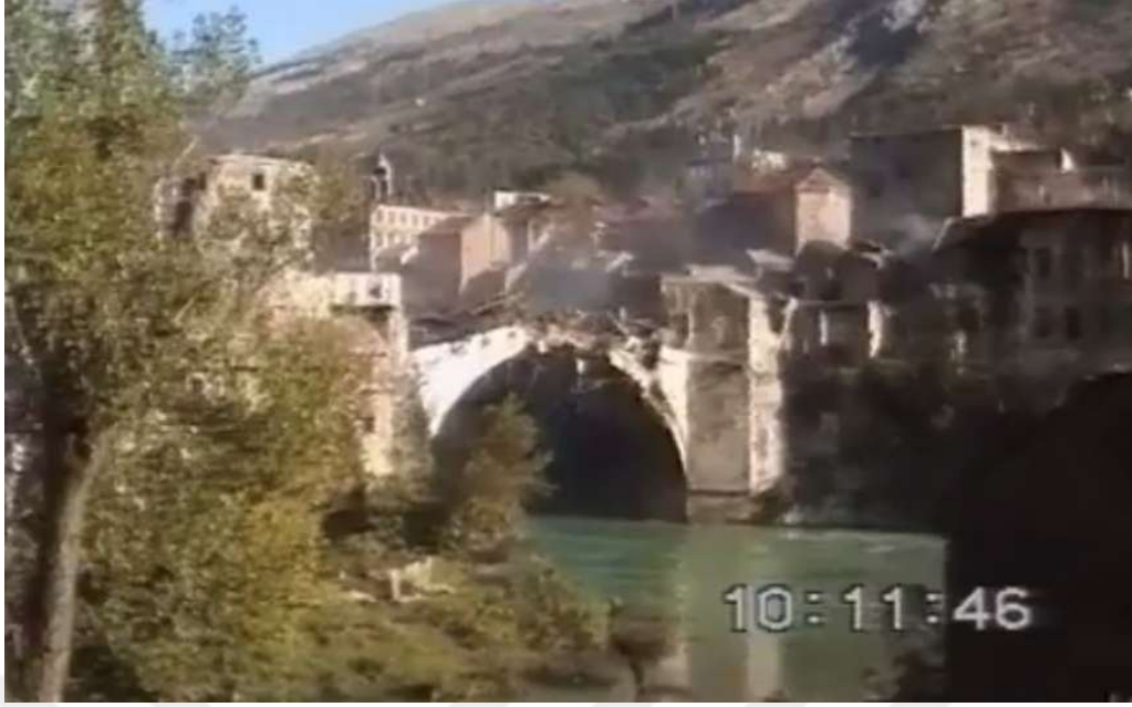
Şekil 5.6: Mostar Köprüsü Savaş Sürecinde Görüntüsü (1993)
