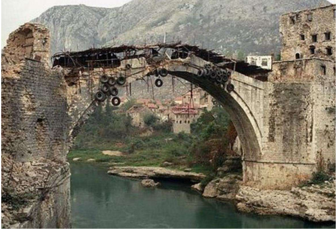
Şekil 5.5: Mostar Köprüsü Savaş Süresinde Koruma Yönetim
