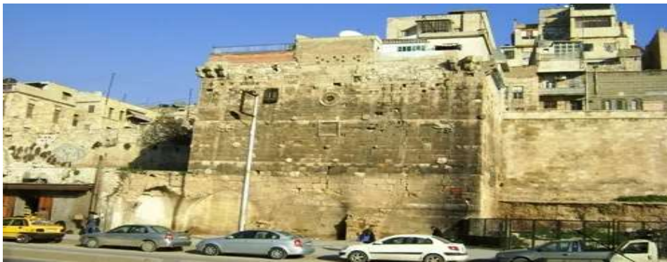
Şekil 3.10: Halep Kenti’ne Ait Surlar
