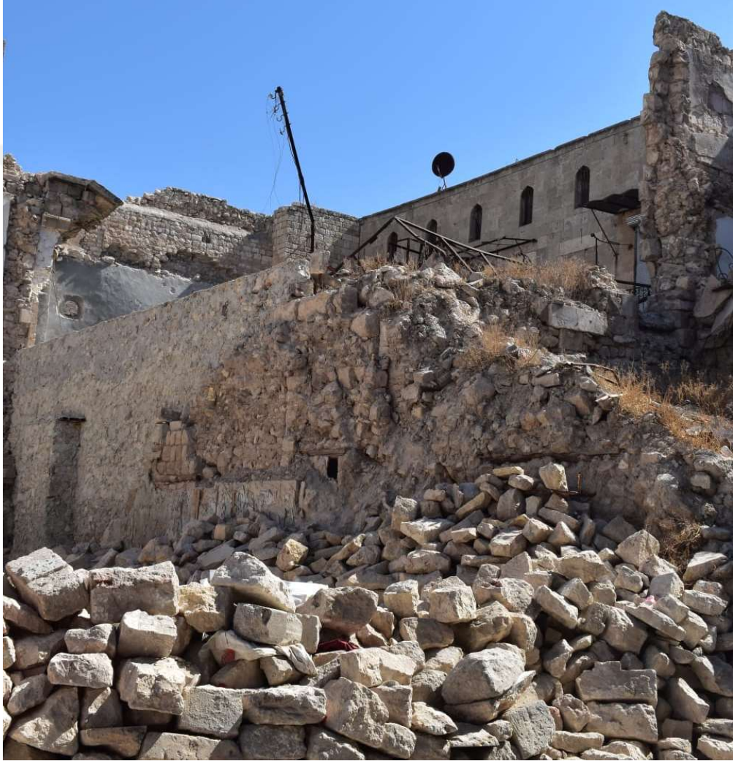
Şekil 4.15: Halep, Medine Kapalı Çarşı'nın Hâlâ Yıkık Olan Cephesi (20.07.2023)
