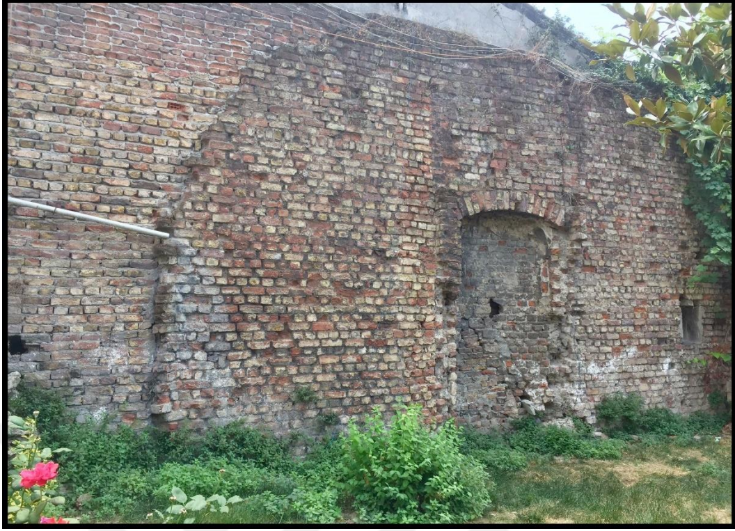
Şekil 3.43: Mihrap Duvarı Kalıntısı (Kuzey Doğudan)
