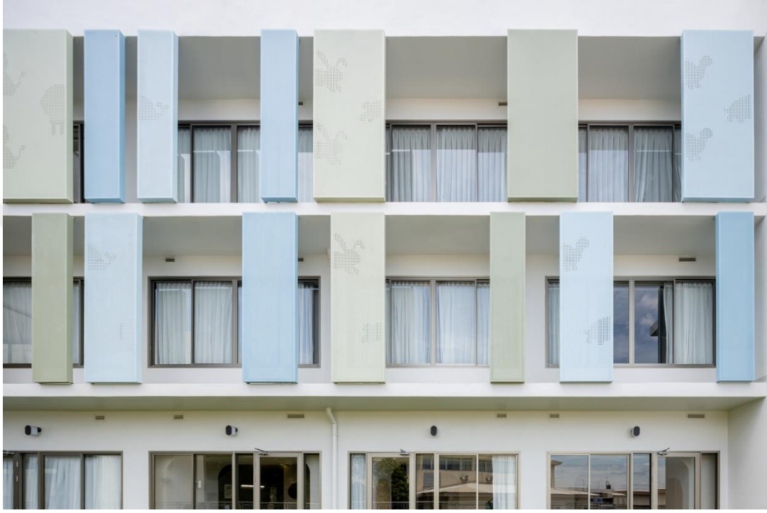
Şekil 4.29: Yapının cephesinde kullanılan delikli güneş kırıcılar.
