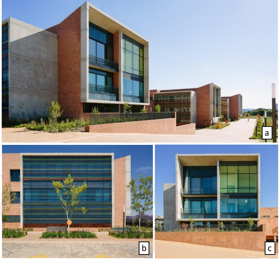
Şekil 4.88: (a) Beton çerçeveler, (b) Renkli güneş kırıcıları, (c) Kanat uçlarında kullanılan renkli cam.
