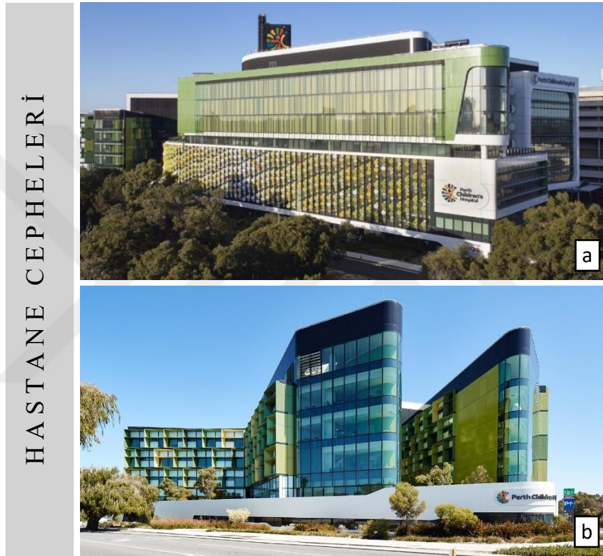
Şekil 4.73: (a) Çift cidarlı cephe, motorlu panjurlar (b) Pencere çerçeveleri.
