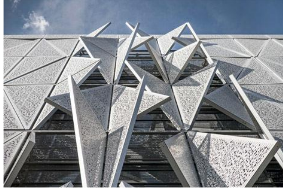
Şekil 2.4: Campus Kolding Cephesi
