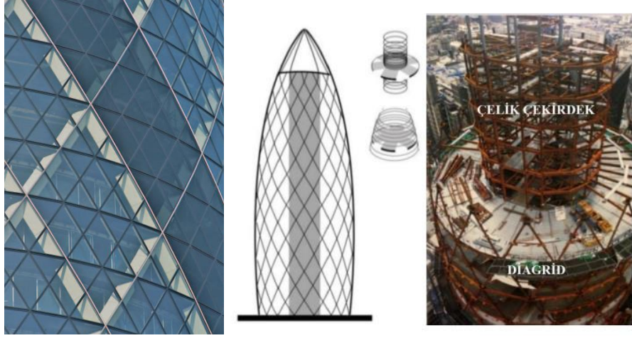
Şekil 4.9: Swiss Re Kulesi'ne Ait Strüktürel Sistem
