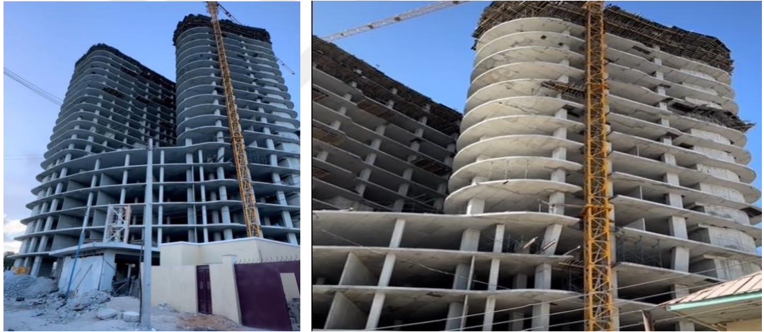
Şekil 3.26: Dahab Binası devam eden inşaat süreci 2020'ler
