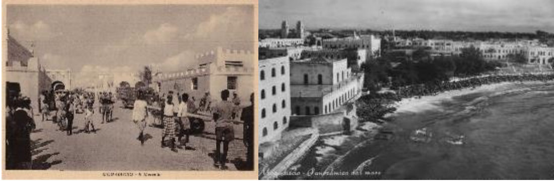
Şekil 3.12: 1950'ler Mogadişu çarşısı sokak görünümü ve solda 1952 yılından sahil yolu ve çevresini görünümü
