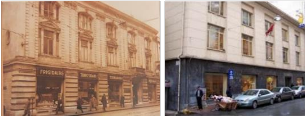
Şekil 4.37 : a) Yapının 1940'larda Burla Biraderlerin kullanımında olduğu dönemde ve henüz orijinal görünümünü koruyan değişmemiş cephesi (soldaki), (Eldem, 2000a: 130) b) Yapının günümüzdeki cephesi, (Uluengin, 2008:111).
