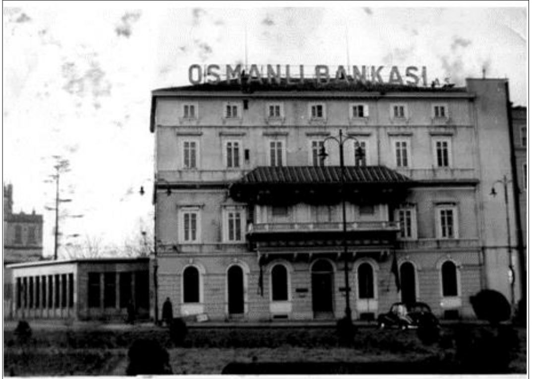
Şekil 2.11 : Bank-ı Osmanî-i Şâhâne Lojmanı Ön Cephe, [4].
