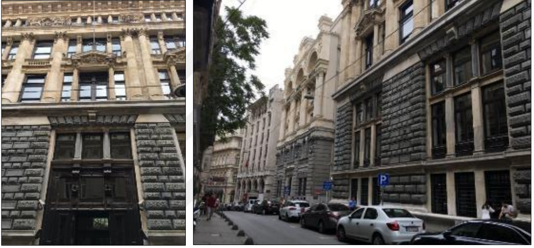
Şekil 3.45 : “Bank-ı Osmanî-i Şâhâne” Binası Giriş (Kuzey) Cephesinden Detay Fotoğrafları, (Esmâ Ünlü, 26.12.2019)
