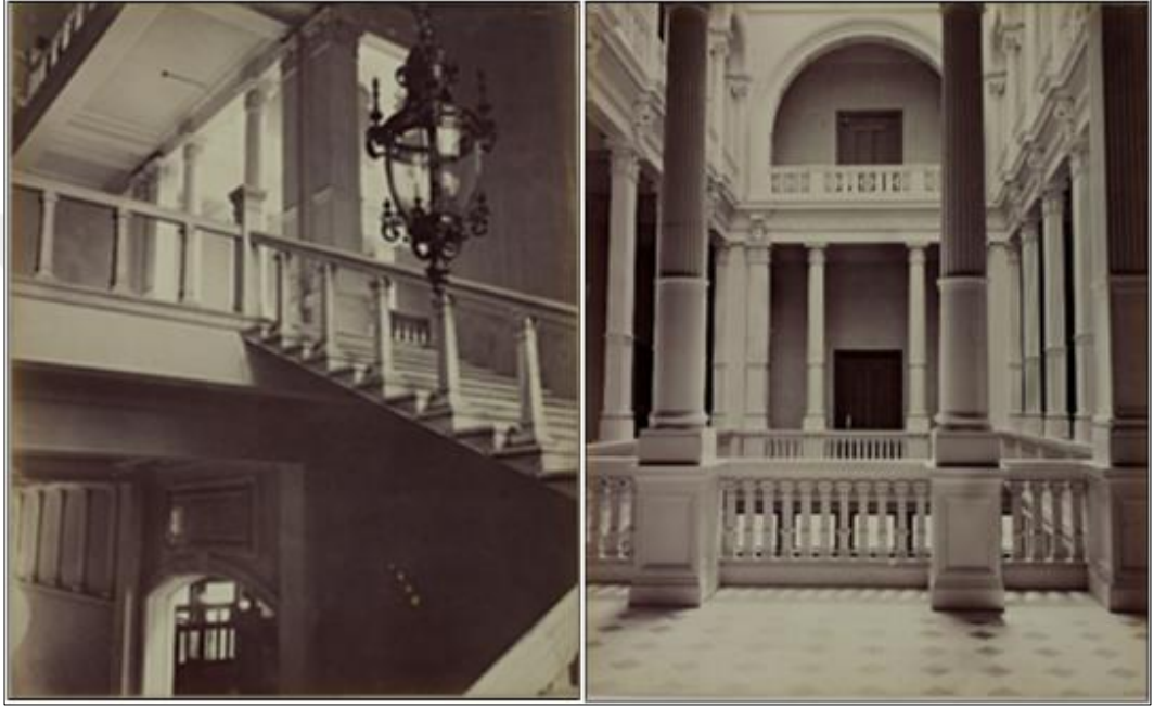
Şekil 3.34 : Banka iç mekânı [19] (ana merdiven solda), [20] (galeri boşluğu sağda).
