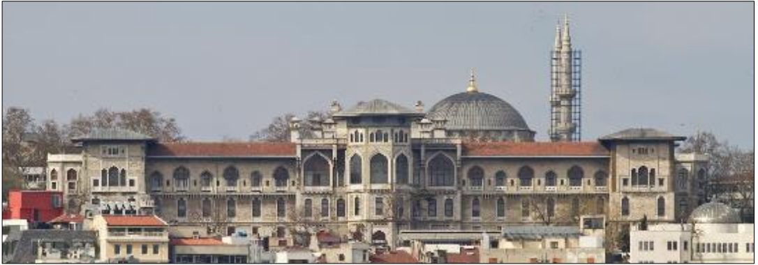
Şekil 4.60 : Düyûn-ı Umûmiye Binası’nın Haliç’e bakan arka cephesi, [43].
