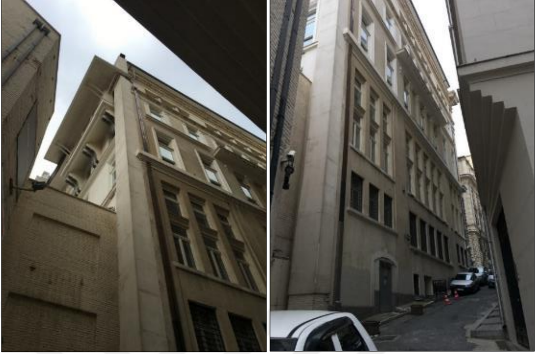
Şekil 3.46 : “Bank-ı Osmani-i Şahane” Binası Yan (Doğu) Cephesinden Detay Fotoğrafları, (Esmâ Ünlü, 26.12.2019)
