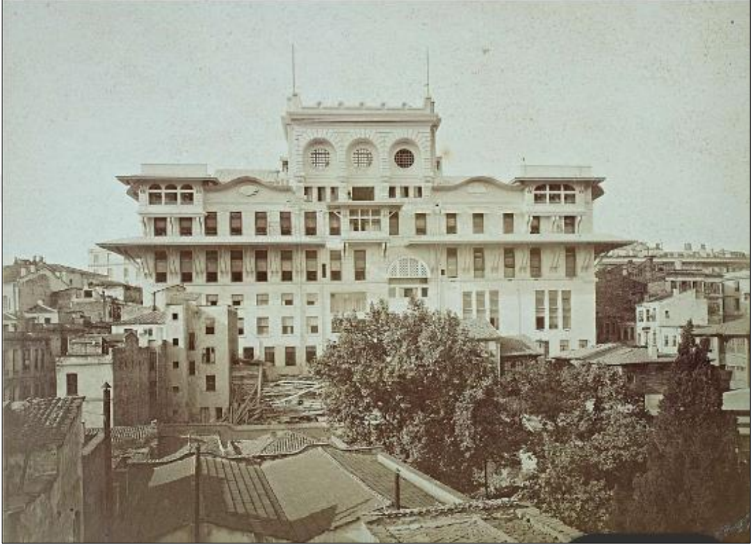
Şekil 3.42 : “Bank-ı Osmanî-i Şâhâne” Binası Arka Cephesi, [23].
