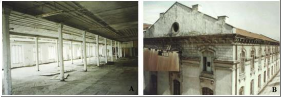
Şekil 4.70 : A Blok restorasyon öncesi döşeme ve tavan detayı (A) ile kuzey ve batı cephesi, (Kılıç, 2019: 36)
