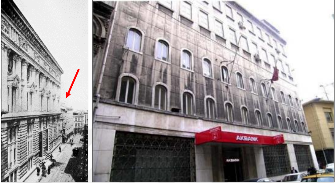
Şekil 4.13: a) Baltazzi Han'ın zemin ve üzerinde iki kattan oluşan hali 1890'larda çekilen bir fotoğrafta görülmekte, (Eldem. E, 2000:119), [30], b) Akbank tarafından kullanılmakta olan ve iki kat ilave edilen Baltazzi Han, (Uluengin, 2008: 41, 100).
