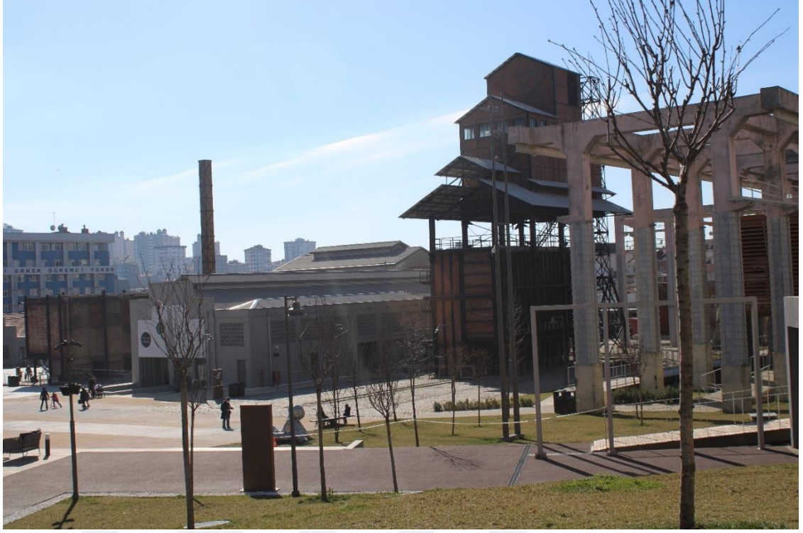
Şekil 4. 59: Hasanpaşa Gazhane Yapısının Fotoğrafları
