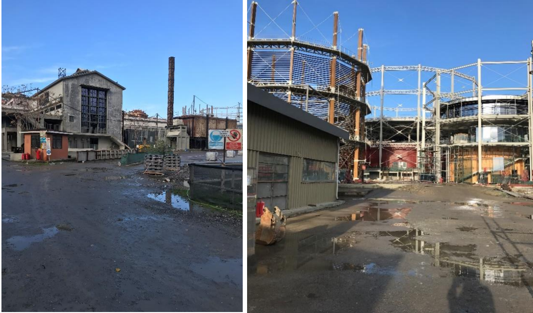
Şekil 4. 57: Gazhane Yapısının Restorasyon Çalışmaları Fotoğrafları
