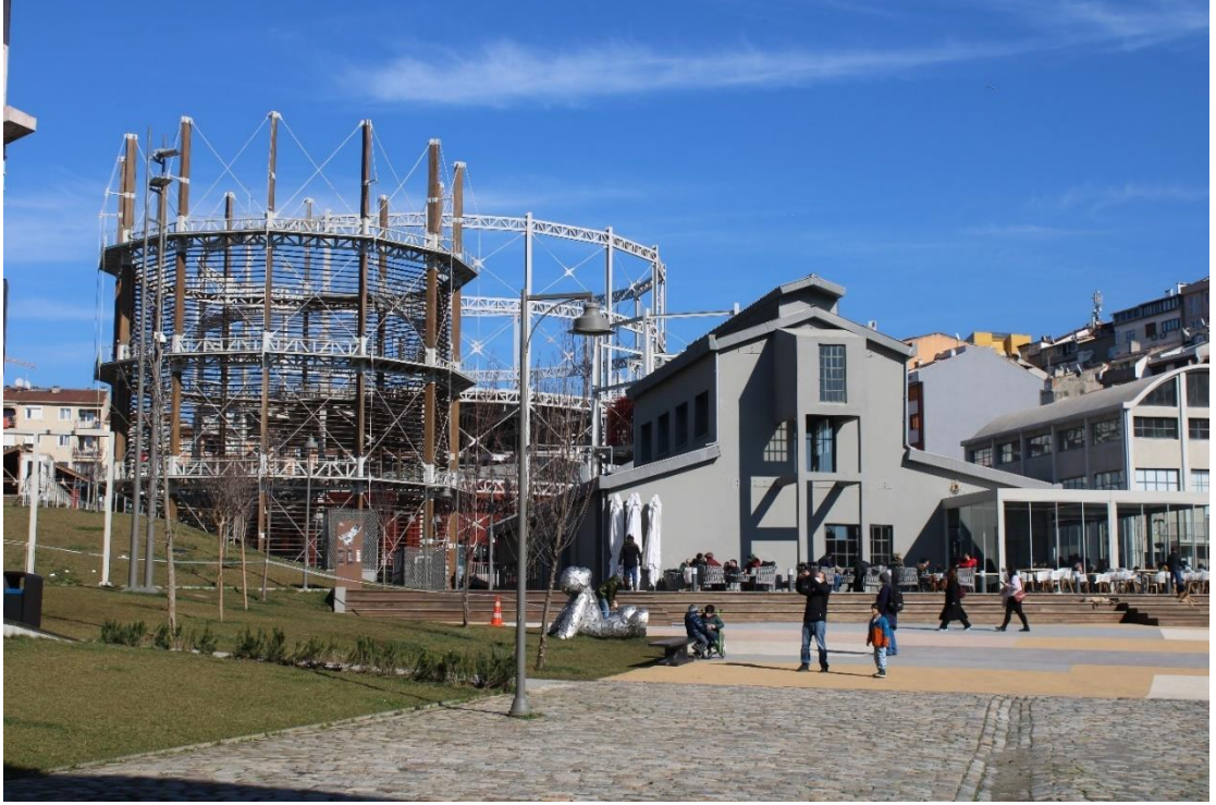
Şekil 4. 58: Hasanpaşa Gazhane Yapısının Fotoğrafları
