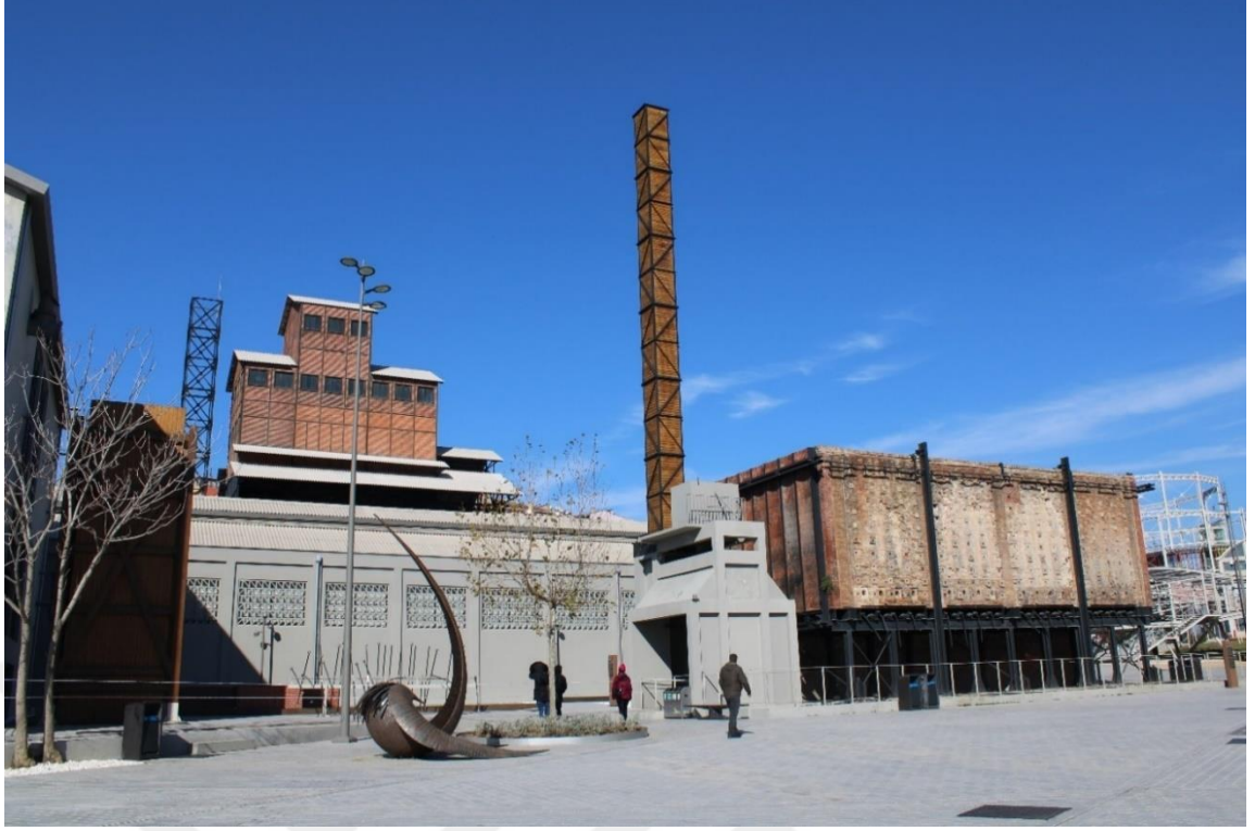
Şekil 4. 61: Hasanpaşa Gazhane Yapısının Fotoğrafları
