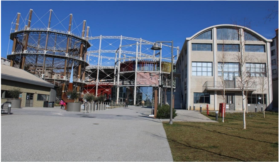
Şekil 4. 60: Hasanpaşa Gazhane Yapısının Fotoğrafları
