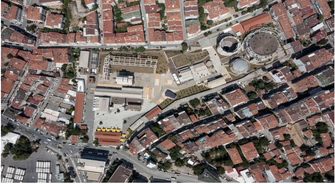
Şekil 4. 50: Hasanpaşa Gazhanesi 2022 Uydü Görüntüsü
