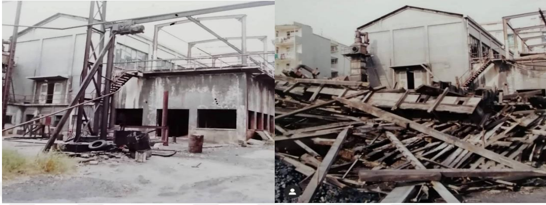
Şekil 4. 53: 1995 Yıkım Kararının Ardından Oluşan Bazı Yıkım Görüntüleri
