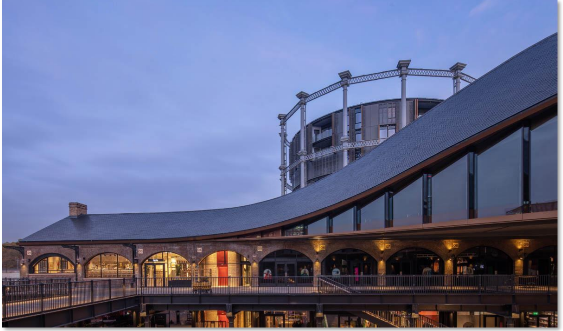
Şekil 4. 11: King Cross Gazometresinin Alışveriş- Kültür Merkezine Dönüştürülmesi
