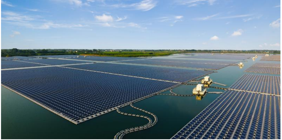
Şekil 3.1. Çin'in Xinji Huainan kentinde bulunan bir yüzer PV projesi
