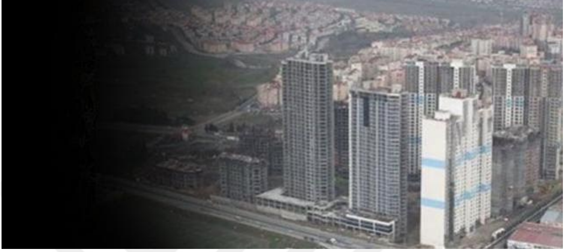
Şekil 3.10: Esenyurt İlçesi Ukra City Projesi
