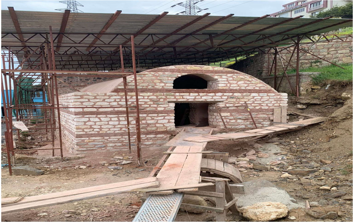
Şekil 4.36: Su Haznesinin Eski ve Yeni Hali
