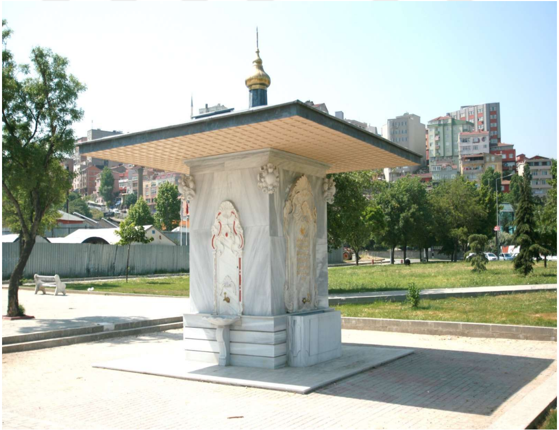
Şekil 4.33: Yeni Çeşme'sinin Eski ve Yeni Hali
