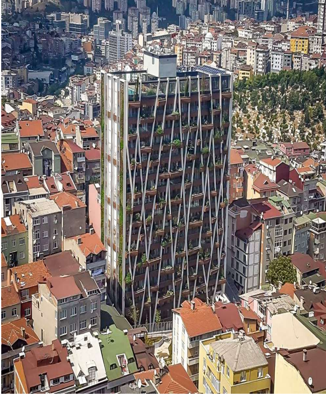
Şekil 4.41: Greenox Residence, Türkiye'nin İlk ve Tek Dikey Ormanı
