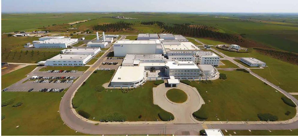
Şekil 4.1.2: Sanofi Türkiye Lüleburgaz Tesisi
