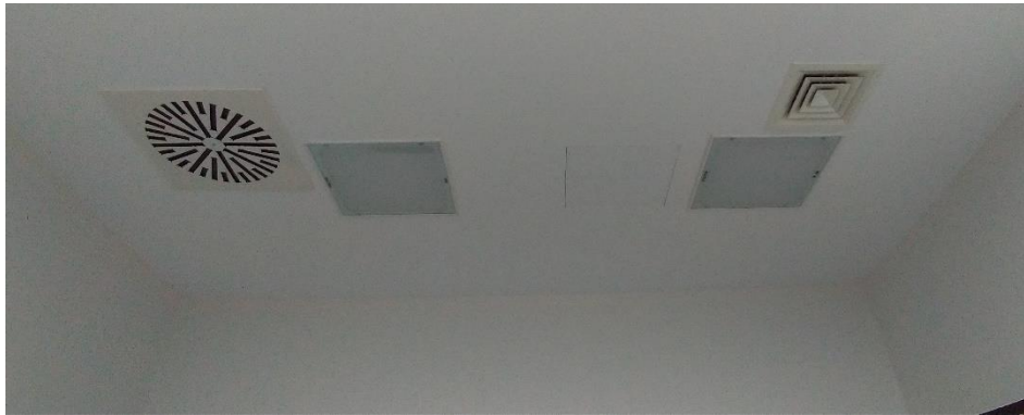
Şekil 4.2.10: Havalandırma menfezleri ve aydınlatma armatürü detayı
