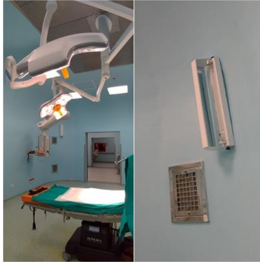
Şekil 4.2.6: Ameliyat lambası, UV armatür ve emiş menfezi detayı
