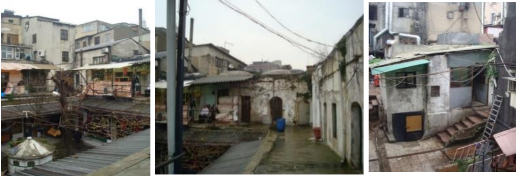
Resim 5.70: Sokaklardaki Aydınlatma Sorunları 2019 (Kişisel Arşiv)
