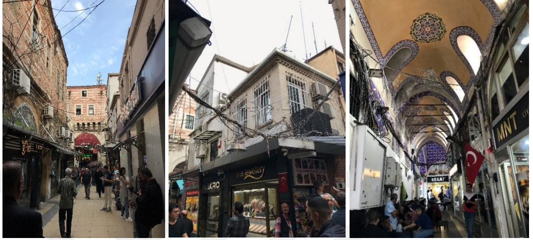
Resim 5.55: Eskiden Borsa olarak kullanılan ve “Kapalıçarşı Borsası” olarak adlandırılan sokak ve Açıktan sarkan ve büyük tehlike arz eden kablolar (Kişisel Arşiv)
