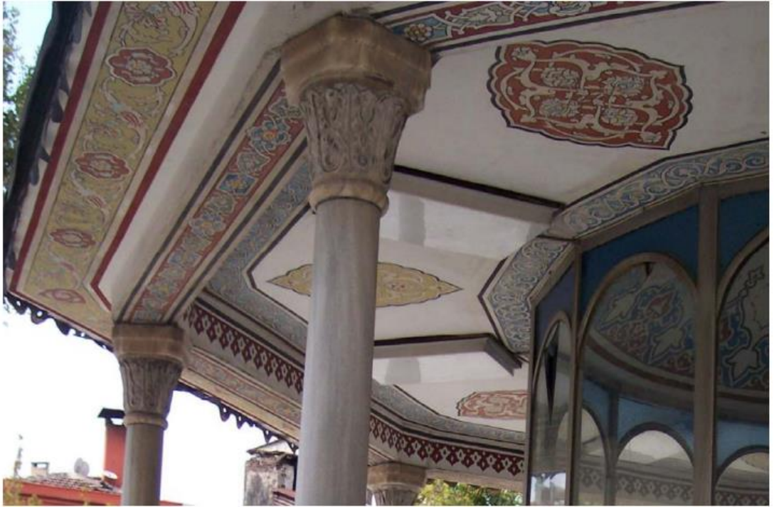
Resim 2. 23: Güzelce Kasım Paşa Camii Şadırvanı Üst Örtü Kalem İşi, Beyoğlu / İstanbul
