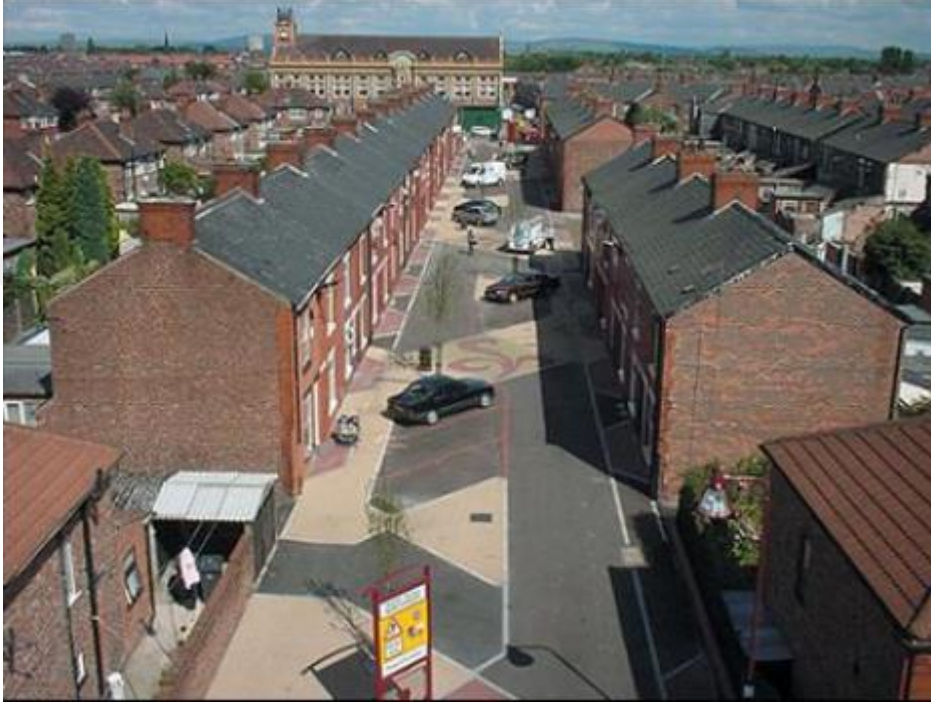
Şekil 3.13: İngiltere’deki ilk “Home Zone” örneği (Stainer Street, Northmoor, Manchester).
