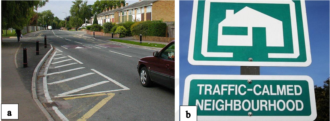
řekil 3.4: (a) İngiltere'de trafiđi sakinleřtirici nlemler: kasisler, kaldırım direkleri ve kaldırım izgileri, (b) Trafik sakinleřtirici blgelere yaklařtıđını belirten trafik tabelası.
