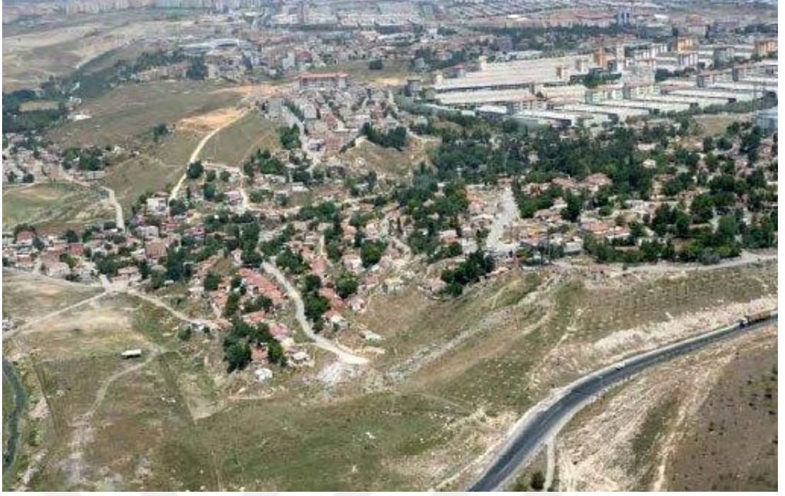
Şekil 2.12: Küçükçekmece Kentsel Dönüşüm Öncesi
