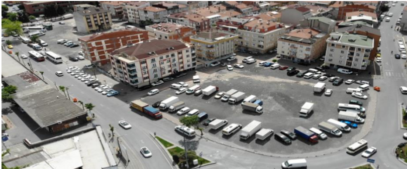
Şekil 4.39: Telsiz Mahallesi kentsel dönüşüm projesi yıkım sonrası görüntüleri
