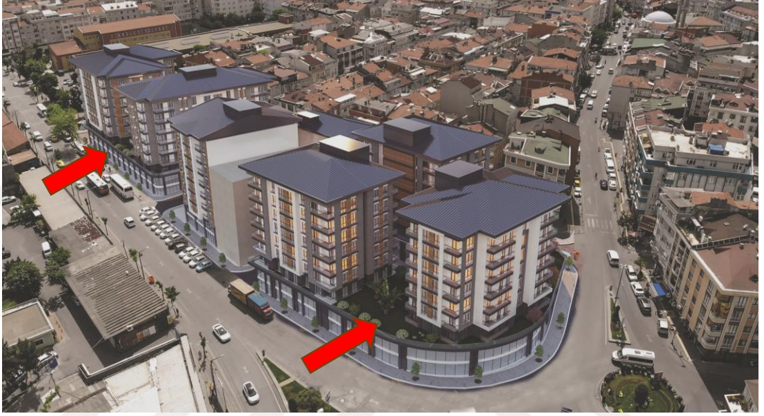
Şekil 4.40: Telsiz Mahallesi Kentsel Dönüşüm Projesindeki yeşil çatı uygulaması
