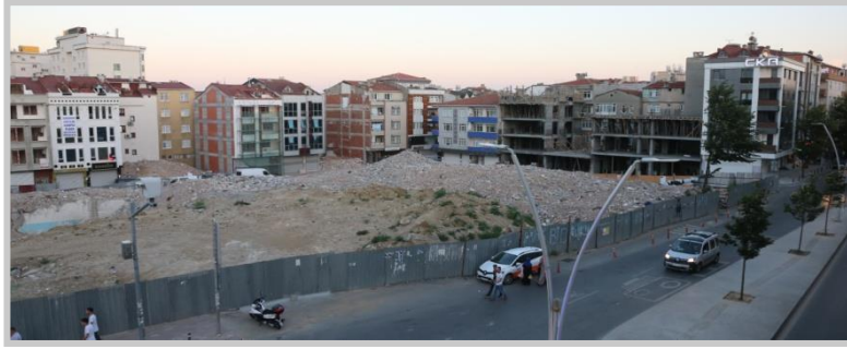
Şekil 4.22: Kuran sitesi 13.01.2017 tarihinde çökmüş olup, yıkım çalışmaları 25.09.2017 tarihinde yapılmıştır
