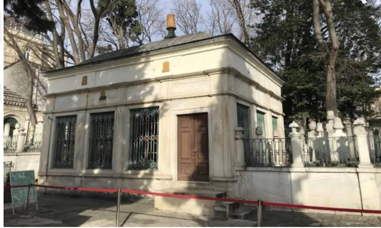
Şekil 1.1: Mevlevî Şeyhi, Mesnevî Şârihi İsmâil Ankaravî'nin Galata (Kulekapısı) Mevlevîhânesi'ndeki Hâlet Efendi Tarafından 1215/1819 Tarihinde Yeniden Restore Edilen Türbesi
