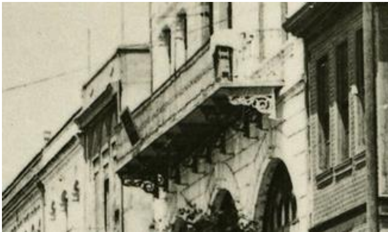
Şekil 4.19: Çalışma alanındaki döküm payanda örneği
