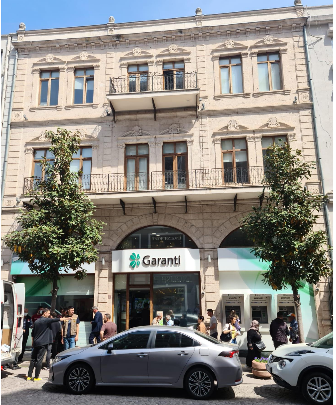
Şekil 4.22: Çalışma alanındaki taş kagir yapıda silme cephe örneği
