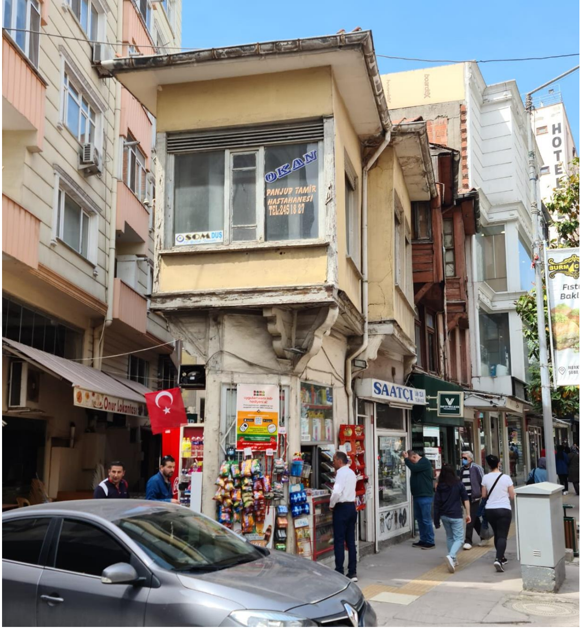
Şekil 4.21: Çalışma alanındaki ahşap silme cephe örneği
