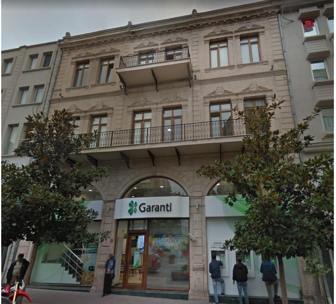
Şekil 4.14: Giriş st ortadan balkon ıkmalı cephe rneęi (Palas Otel)
