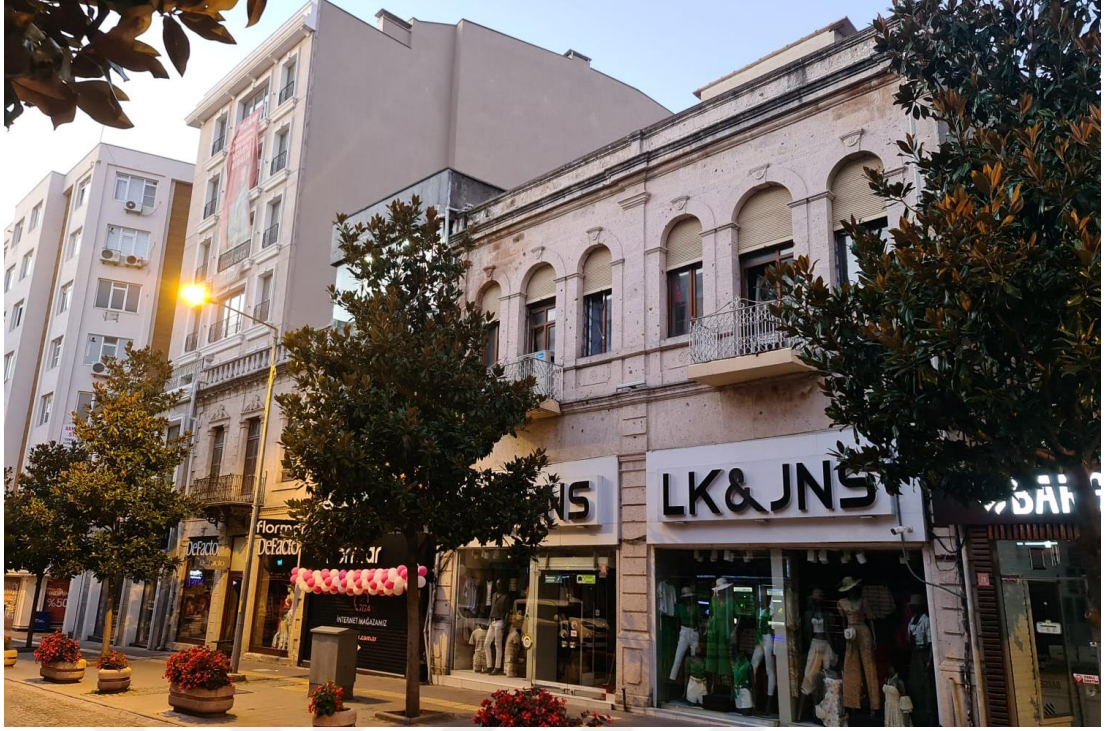
Şekil 3.10: Alandaki tescilli yapının yüksek katlı yapılara oranı (2022)
