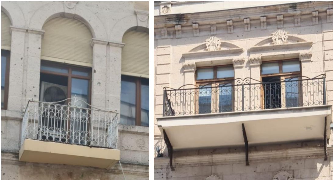
Şekil 4.25: Çalışma alanında bulunan korkuluk örnekleri
