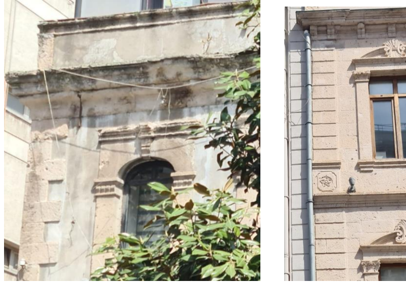
Şekil 5.11: Çalışma alanında bulunan yüzey ve parça kayıp örneği
