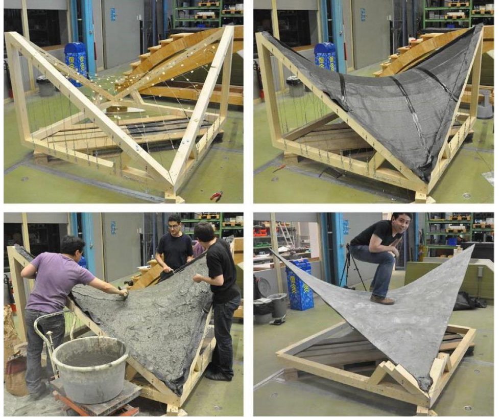
Şekil: 5 Kabüğün yapım aşamaları (Veenendaal ve Block 2014, 39-50).
