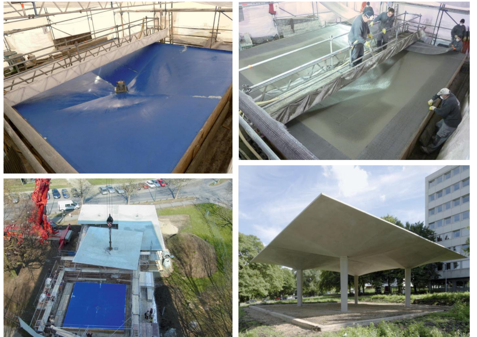
Şekil: 6 TRC kabüğün üretim aşamaları ve son hali (Scholzen ve diğerleri 2015, 106-114).
