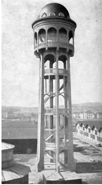
Resim 6. Almanya, Singen 1907 yapımı betonarme su kulesi (URL-6).
