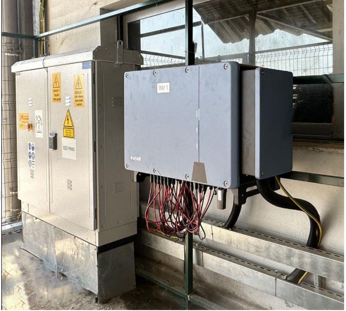
Şekil 3. 10: Pano ve Evirici Saha Uygulama Fotoğrafi
