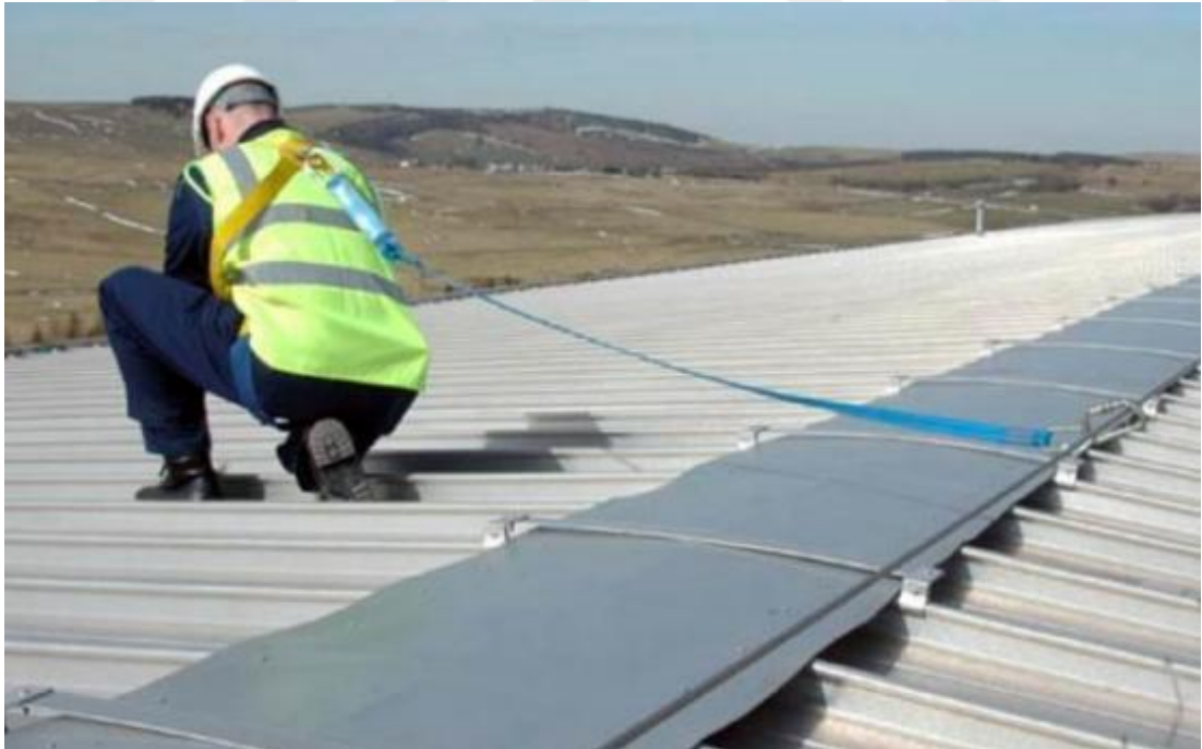
Şekil 2. 2: Çengelli halat ve Paraşüt Tipi Emniyet Kemer Uygulaması
