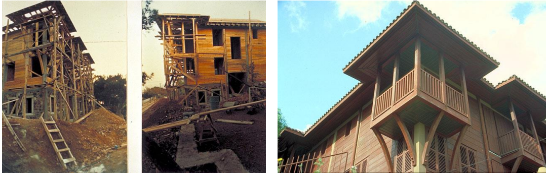
Şekil 4.15: Ataç evi yapım aşamaları ve köşe çıkması
