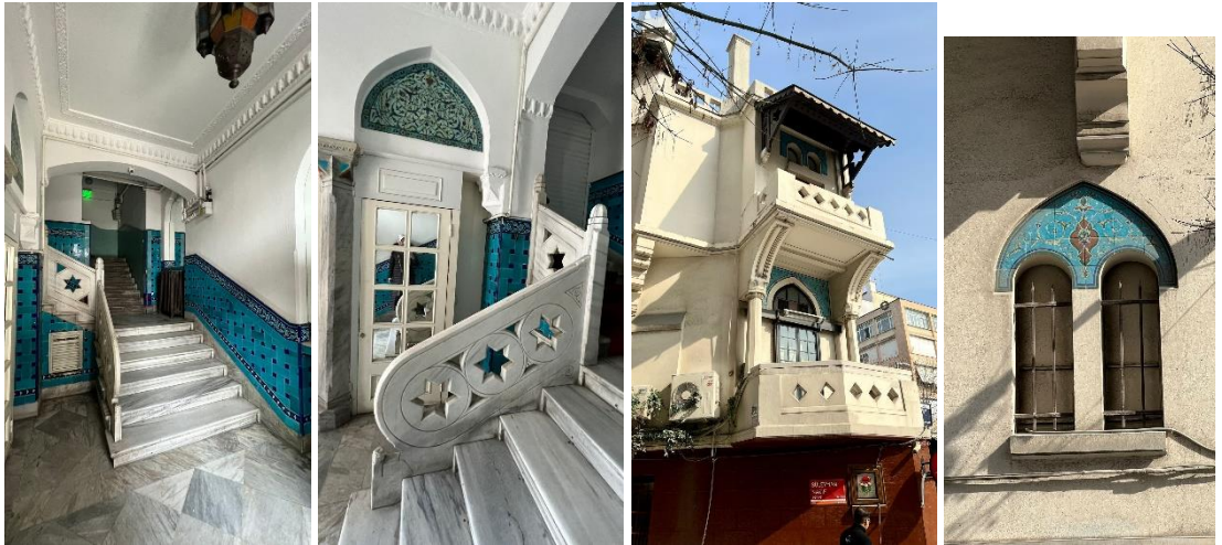
Şekil 4.8: Sırasıyla; giriş holü, giriş holü detayı, köşe çıkması, pencere detayı
