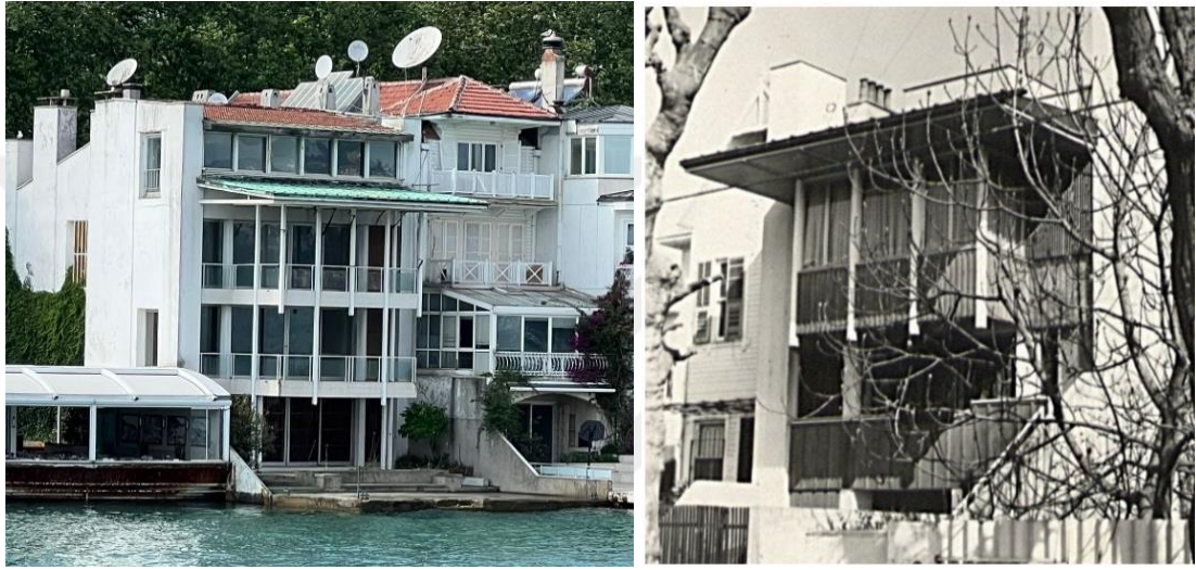
Şekil 4.4: Yalı cephesi (solda) ve yol cephesi (sağda)
