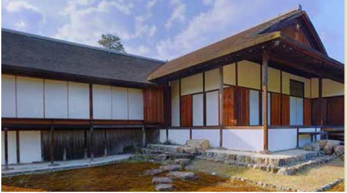
Şekil 2.14: Katsura Müstakil Sarayı ahşap direkler üzerinde yükseltilmiştir
