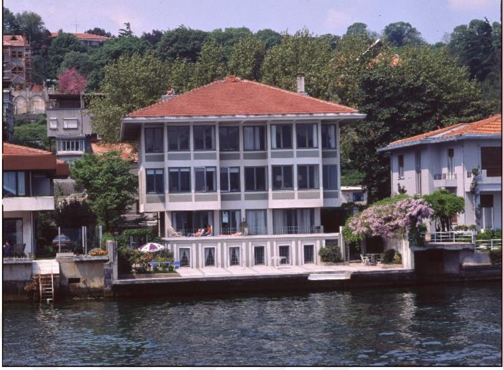
Şekil 4.38: Bilimer apartman yalısı deniz cephesi
