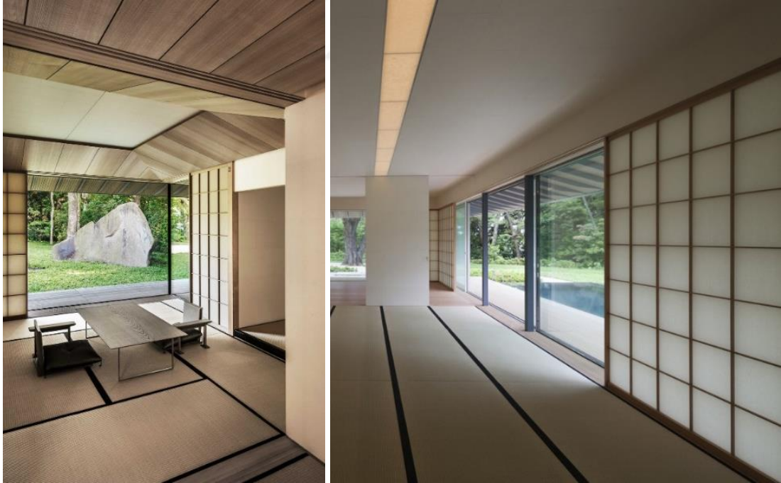
Şekil 3.40: Ahşap, kağıt ve tatami hasırların birlikte kullanımı
