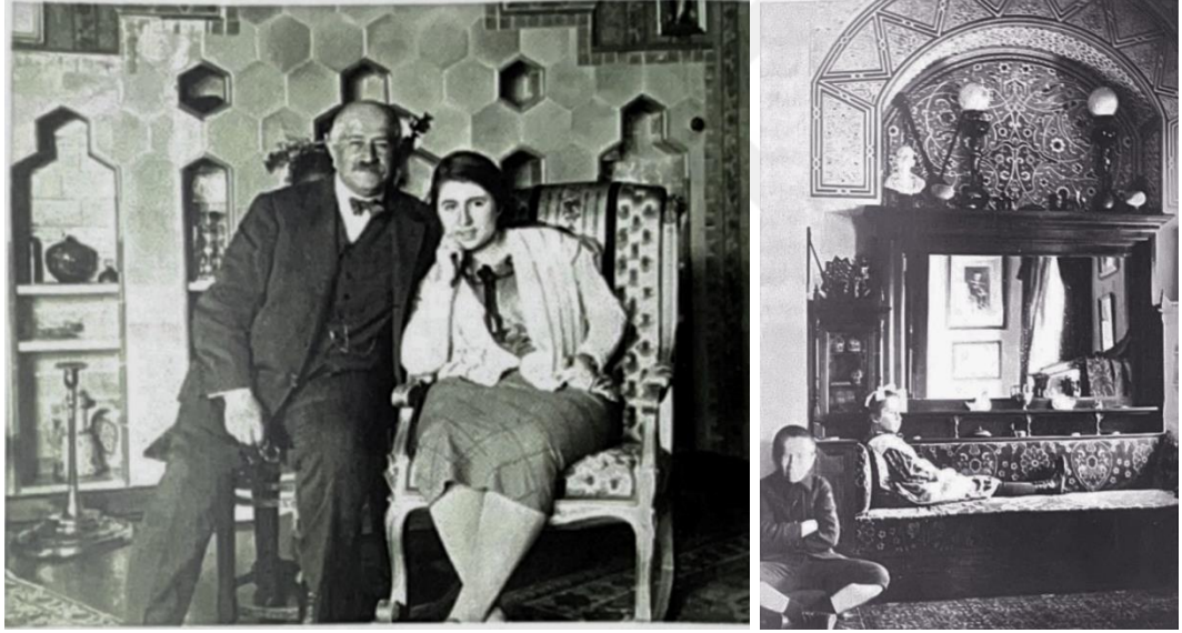
Şekil 4.9: Vedat Tek ve kızının arkasında duvar nişleri görülmektedir (solda), niş içine yerleştirilmiş sedir oturma elemanı (sağda)
