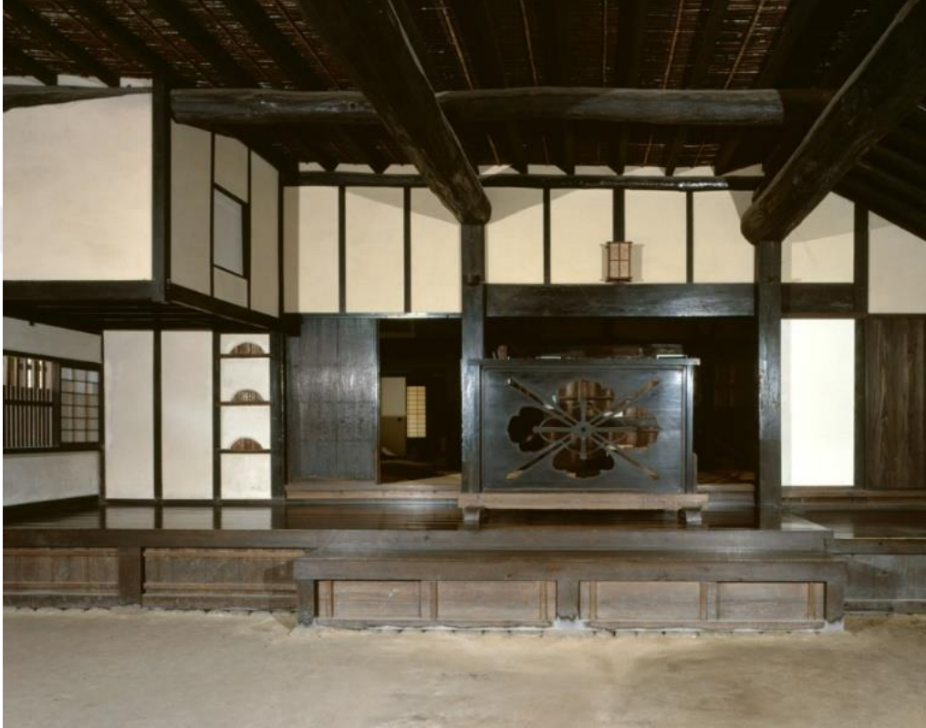
Şekil 2.25: Yoşimura evi toprak zemin ile yaşama mekânı arasındaki iç veranda, hiroşiki
