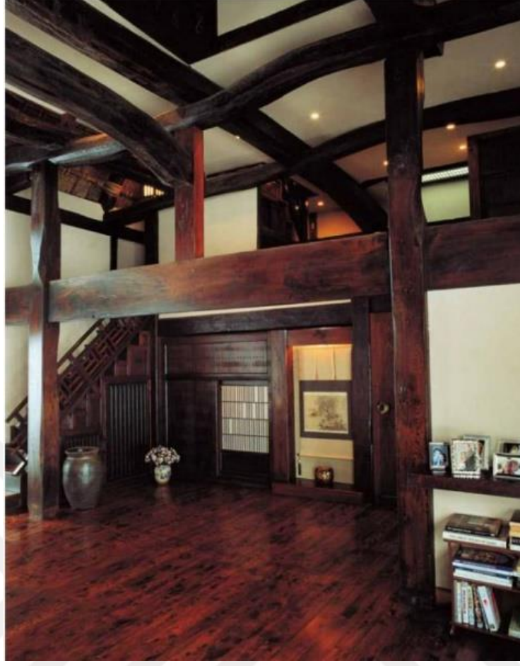
Şekil 2.46: Koyagumi çatı sistemi
