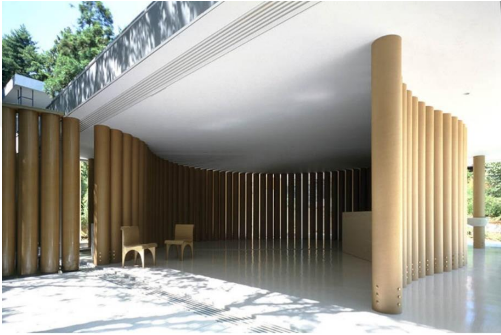
Şekil 3.27: Kağıt Ev’deki kağıt tüpler hem taşıyıcı hem de bölücü duvarlardır
