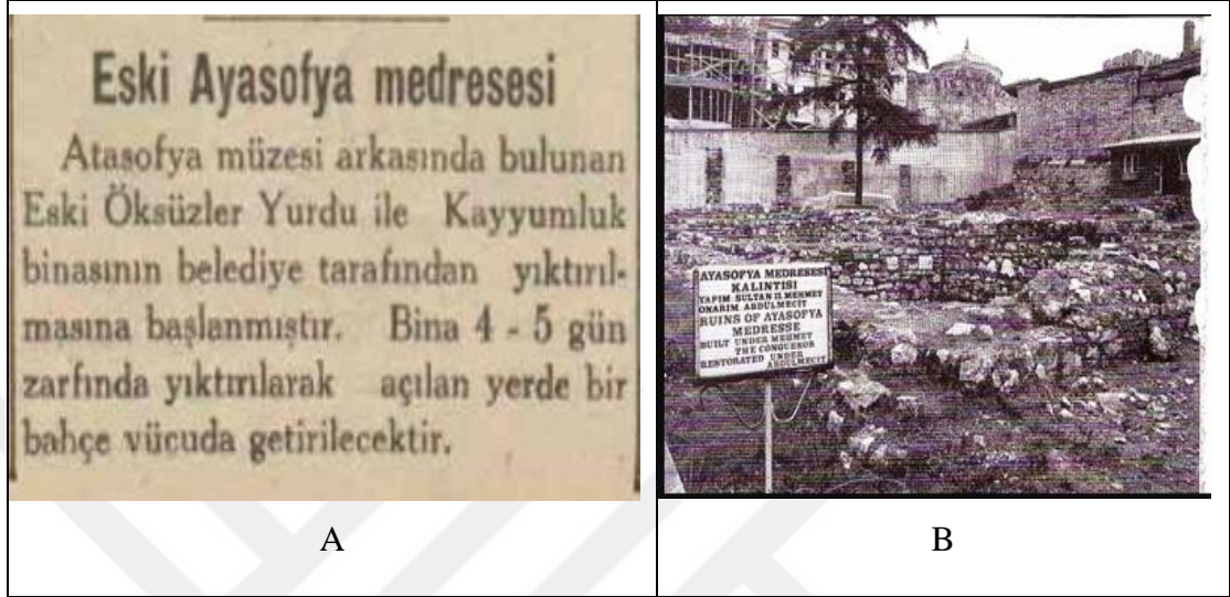
Şekil 3.3: A) Ayasofya Medresesinin yıkıtılma haberi. B) Medrese temelleri 1982. Tabela; “Ayasofya Medresesi Kalıntısı, Yapım: Sultan II. Mehmet, Onarım: Abdülmecit”, yazılmıştır.
