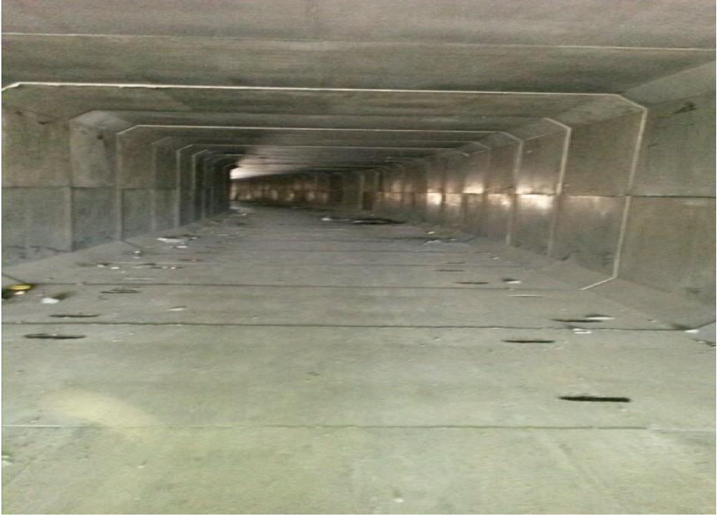
Şekil 4. 50: Güzergâh 2 Nolu Kısım Islah Sonrası
