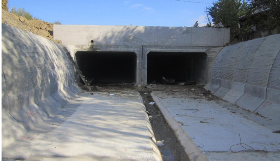
Şekil 4. 56: Güzergâh 4 Nolu Kısım Islah Sonrası
