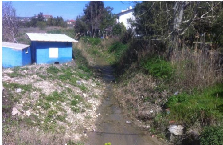
Şekil 4. 52: Güzergâh 3 Nolu Kısım Islah Öncesi
