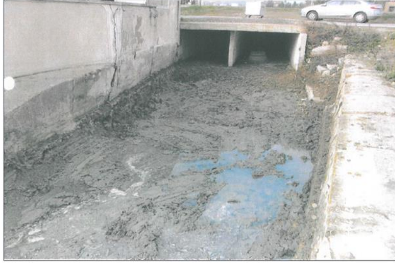
Şekil 4. 57: Güzergâh 5 Nolu Kısım Islah Öncesi
