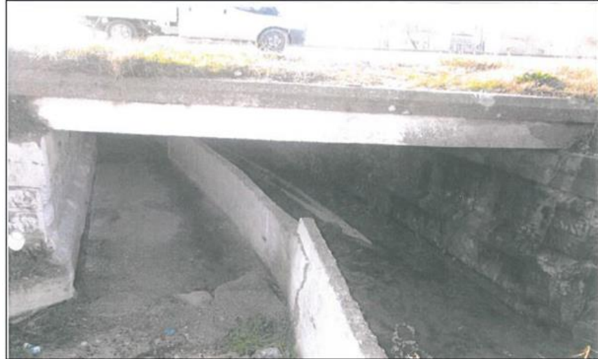
Şekil 4. 55 Güzergâh 4 Nolu Kısım Islah Öncesi
