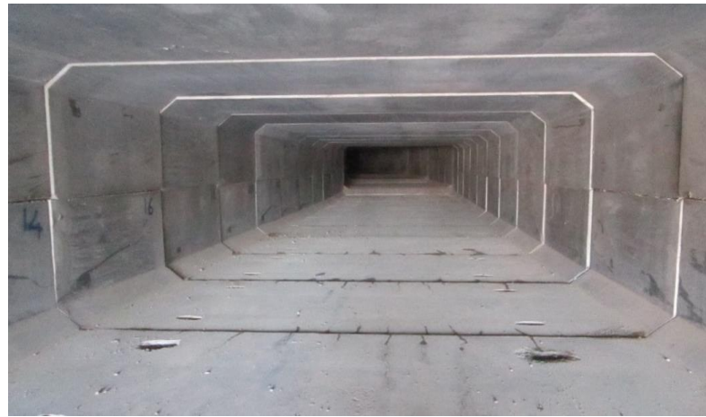
Şekil 4. 58: Güzergâh 5 Nolu Kısım Islah Sonrası
