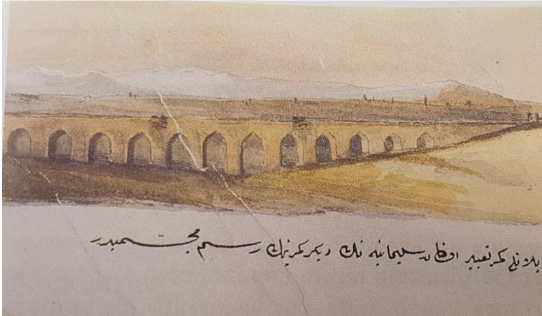
Şekil 1.10: Halkalı Su Yolu Sistemi'nde yer alan Avasköy Kemeru'nin mansaptan görünümü, Köprülü Kütüphanesi (2442/2)
