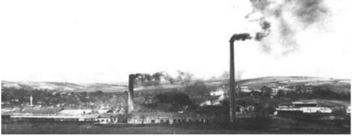
Şekil 1.46: 1942’de Terkos Su Pompa İstasyonu.
