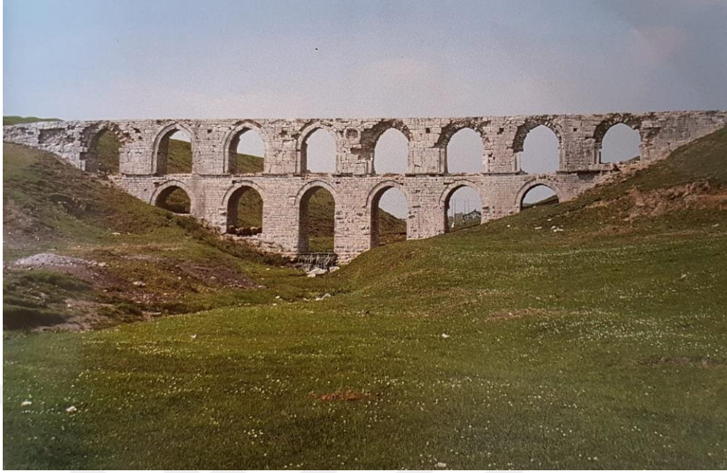
Şekil 1.9: Halkalı Su Yolu Sistemi'nde Yer Alan Alipaşa Kemeru'nin Mansaptan Görünümü, 2000
