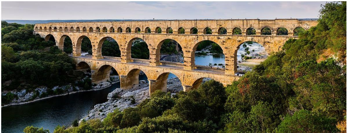
Şekil 2.39: Pont du Gard Su Kemerini.
