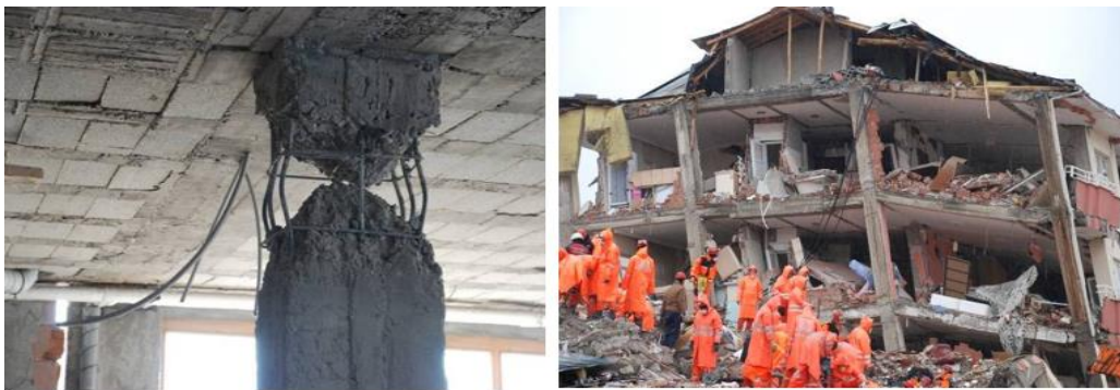
Şekil 7.85: Erciş kent merkezi yetersiz sargı donatısı(sağda), Asmolen döşeme ağır malzeme ile cephe kaplamalı ağır bina örnekleri (solda)
