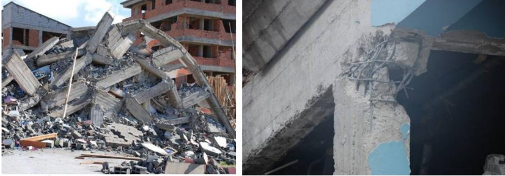
Şekil 7.83: Yanal dayanımı düşük, bağlayıcısız yığma elemanlarının burulma örneği,
