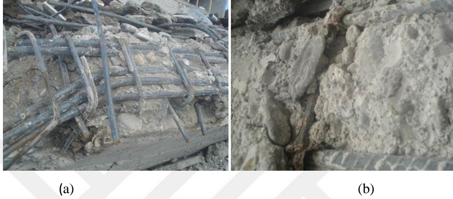
Şekil 7.74: (a) Nervürsüz inşaat demiri ile nervürsüz ve (b) nervürlü demirin birlikte kullanıldığı yapı elemanları
