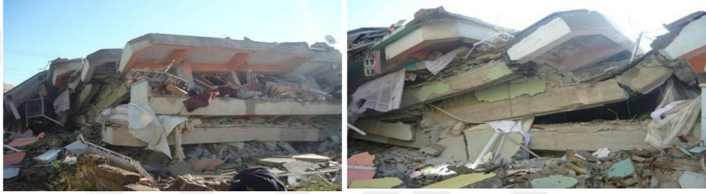
Şekil 7.81: Yanal ötelenme ve burkulma hasarı ile çökme mekanizması oluşmuş yapı örneği
