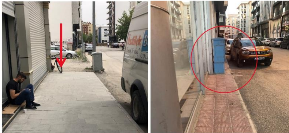
Şekil 7.106: Aniden kesilen kaldırım ve kaldırımı kapatan trafo örneği
