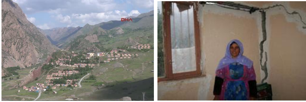
Şekil 7.94: Van Konalga Köyü kötü zeminde inşa edilen yapılarda heyelan etkisi
