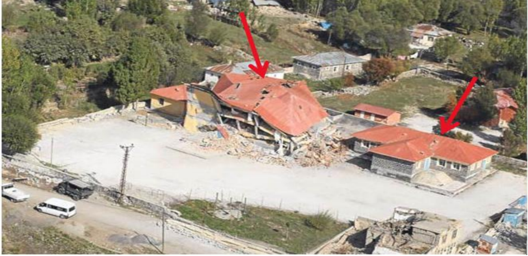
Şekil 7.91: Van Gedikbulak Köyü 1952’de yapılan (yıkılmayan-sağda), 1988’de yapılan (yıkılan-solda) köy okul binaları
