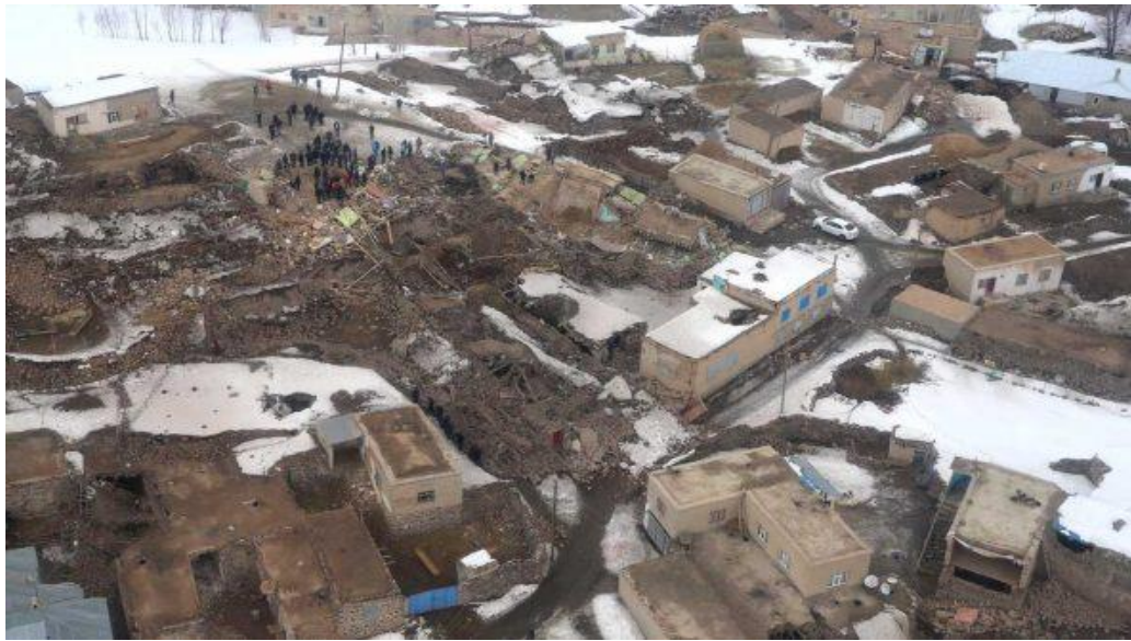
Şekil 7.91: Deprem görmüş bir köyde yığma yapı hasarı (Van-Başkale 2021)
