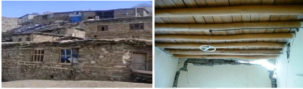
Şekil 7.61: Taştan yapılmış damı ahşap kirişle kapatılmış Van köyü evi
