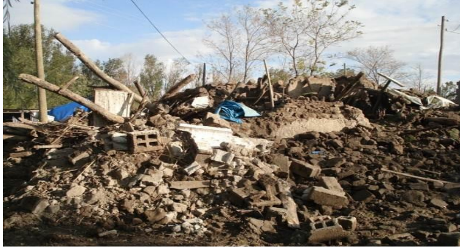
Şekil 7.88: Van Göllü Köyü depremde yıkılan yığma yapı enkazı
