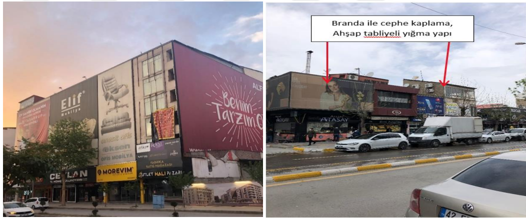
Şekil 7.44: Cumhuriyet caddesi cephe giydirmesi yapılmış yığma yapı örnekleri
