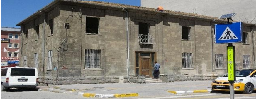
Şekil 7.8: Van tekel binası-2021
