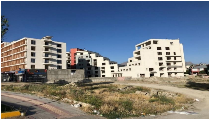
Şekil 7.48: Van merkez emsalden fazla alan kullanımı örneği
