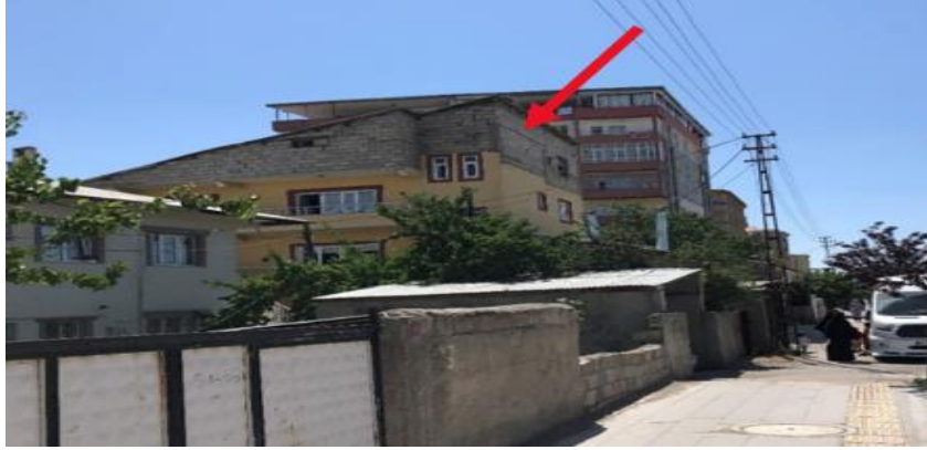
Şekil 7.76: Kalkan duvar kullanımı, Van Selimbey Mahallesi
