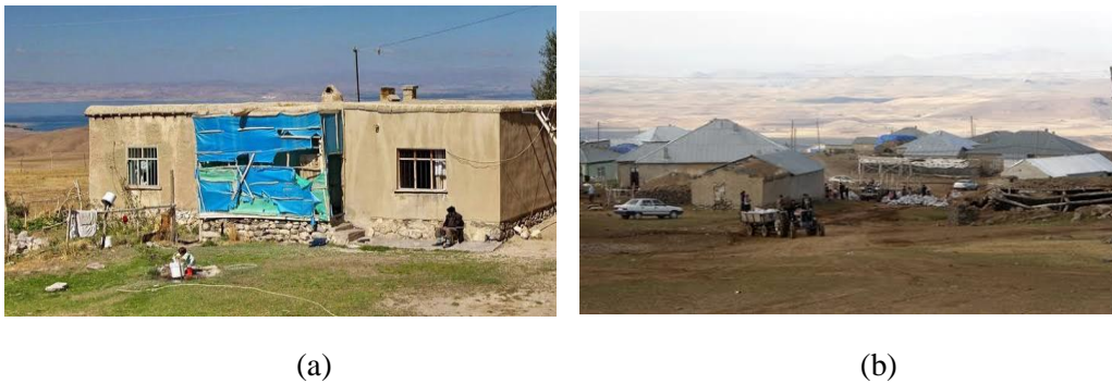
Şekil 7.62: (a) Kerpiç ev köyü yapı örneği, Van Özalp Tepedam Köyü, (b) Briket ve sac çatı yaygın uygulama örneği, Erciş Gözütok Köyü
