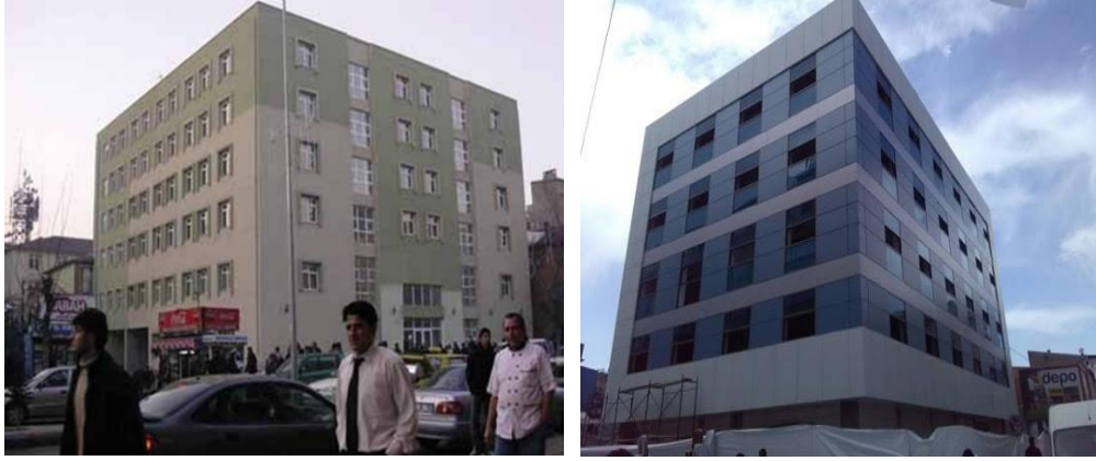
Şekil 7.43: Van Telekom binası giydirilmiş bina örneği
