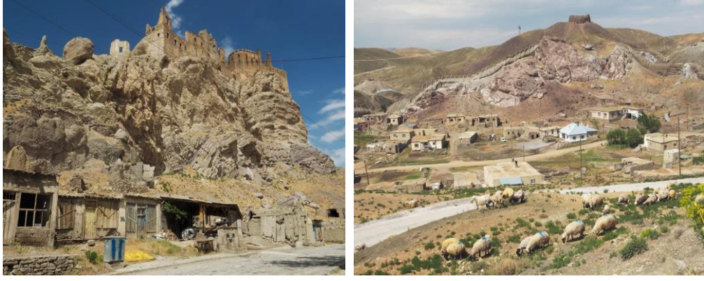
Şekil 8.12: Van Hoşap Kalesi batı tarafı izinsiz yapıların işgali
