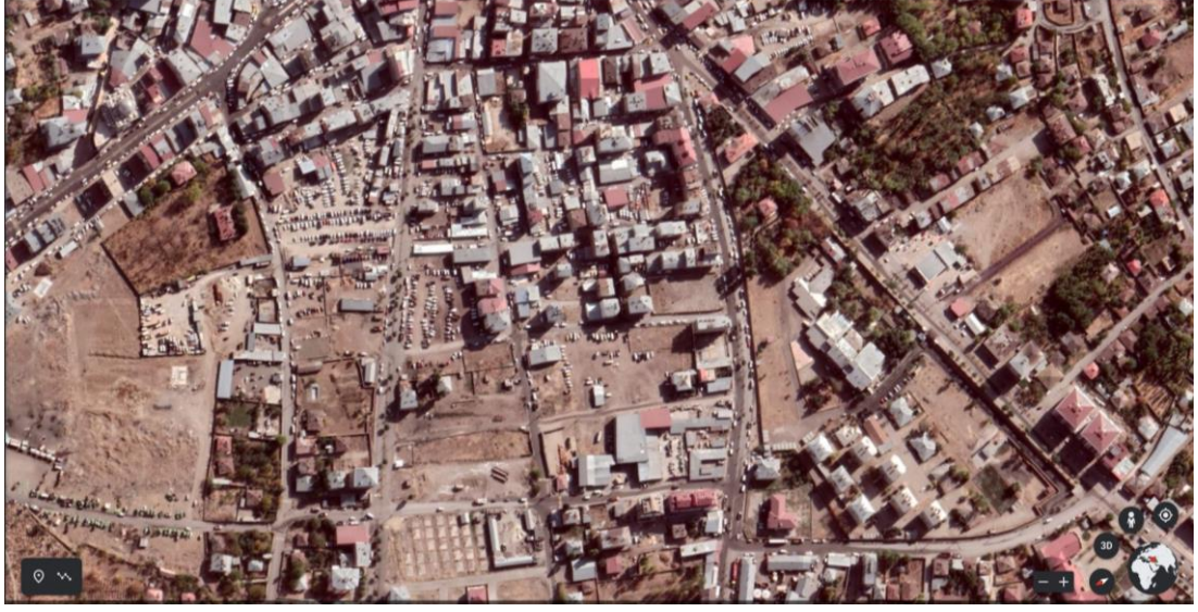
Şekil 7.57: Erciş'te kent merkezindeki plansız yapılaşmanın hâkim olduğu bölgeden bir kesit
