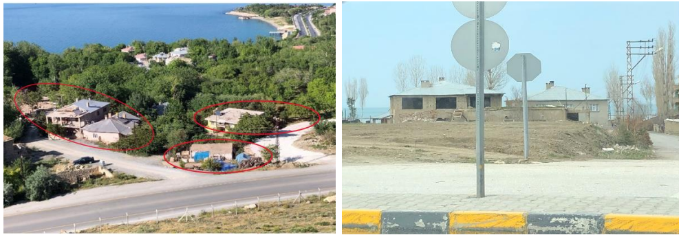
Şekil 8.16: Edremit sahil kesiminde ruhsatsız, riskli yapılar
