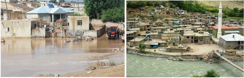
Şekil 7.97: Dere yatağına kurulmuş riskli yerleşim örneği, Van Bilgi Köyü
