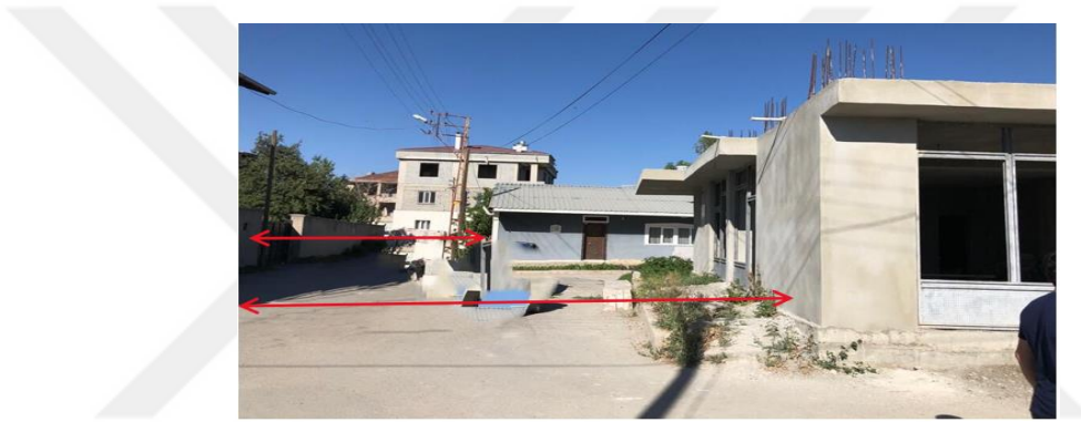
Şekil 7.36: Yoldan yetersiz çekme mesafeli yapı örnekleri, Van Eminpaşa Mahallesi
