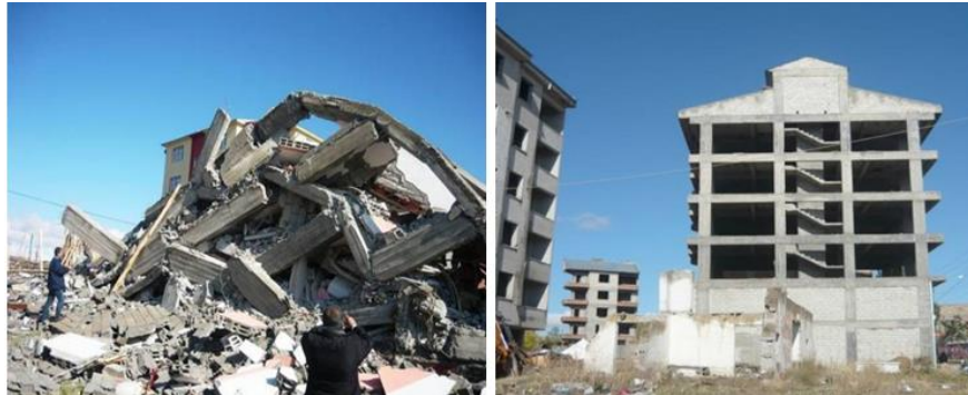
Şekil 7.92: Yıkılan yapıların hemen yanında bulunan hasarsız betonarme yapılar
