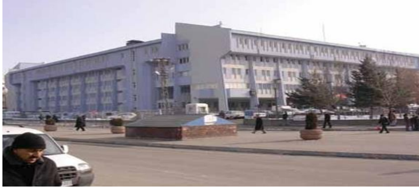
Şekil 7.10: Van valilik binası
