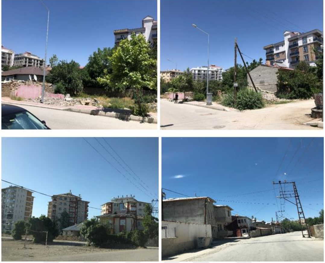
Şekil 7.33: Planlama disiplini olmayan kötü tasarım yapı örnekleri Van Şerefiye Mahallesi-2021
