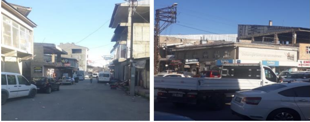
Şekil 7.58: Erciş kent merkezinde eksik, ruhsatsız yapılardan oluşan sokaklar
