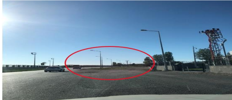
Şekil 7.109: Yol ortasında aydınlatma direği ve aniden biten yol, Van Kalesi civarı-2021
