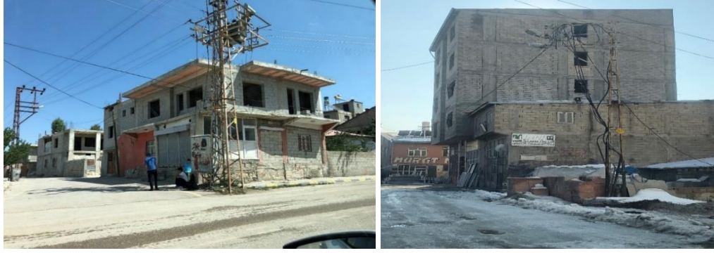
Şekil 7.41: Kent dokusunu bozan eksik yapı örnekleri, Bostancı Mahallesi
