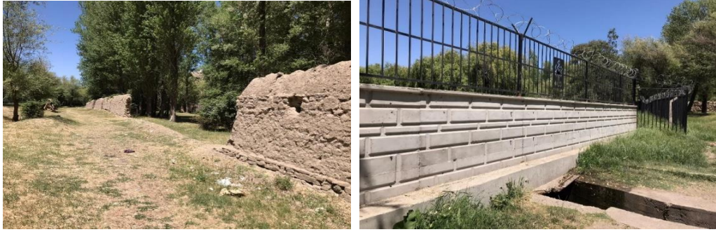
Şekil 8.13: Van Kalesinde Urartulardan kalma duvar yerine yapılan beton duvar
