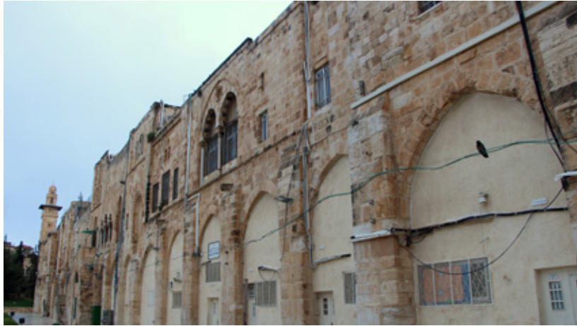
Re. 55.14 – 55.15 Mescid-i Aksa Kuzeydoğu ve kuzeybatı revakları ile üzerlerinde yer alan doğudan batıya doğru sırayla Dividdar, Basitiye, Eminiyye, Farisiyye, Esardiye, Melekiye ve Caviliyye Medreseleri (IV Arşivi)
