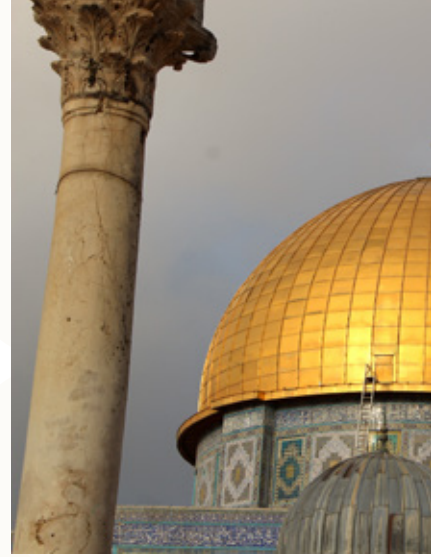
Resim 24. Sahre'nin üzerindeki kubbeye yazılan Kur'an Suresi, alttaki 8 cephesinde yer alır (İYV Arşivi)
