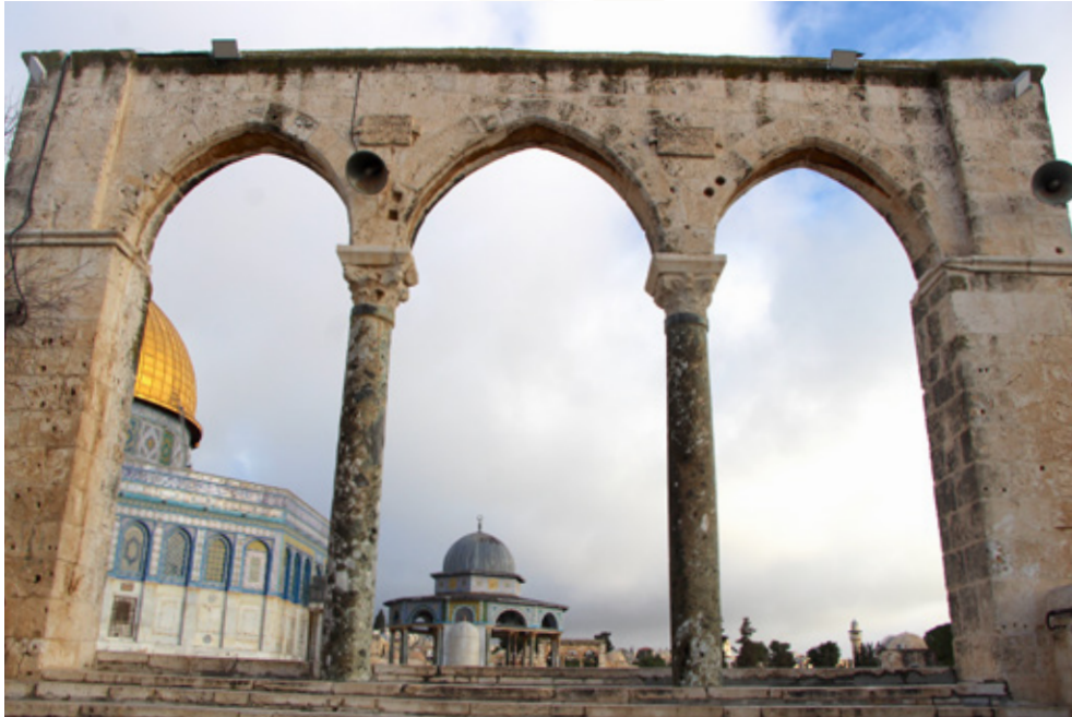
R. 55. 10 Güneydoğu Kemerleri (İVV Arşivi)
