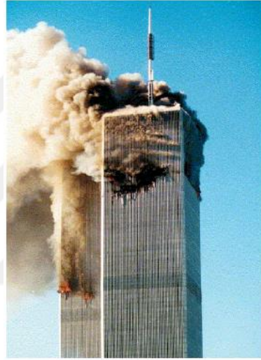
Şekil 4.24: Dünya Ticaret Merkezi Yangını (11 Eylül 2001), uçak çarpmasıyla çıkan yangın sonucu yıkılan yapının taşıyıcı sisteminin püskürtme sıvalarla korunması
