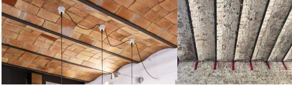
Şekil 4.57: Volta döşeme uygulama örnekleri
