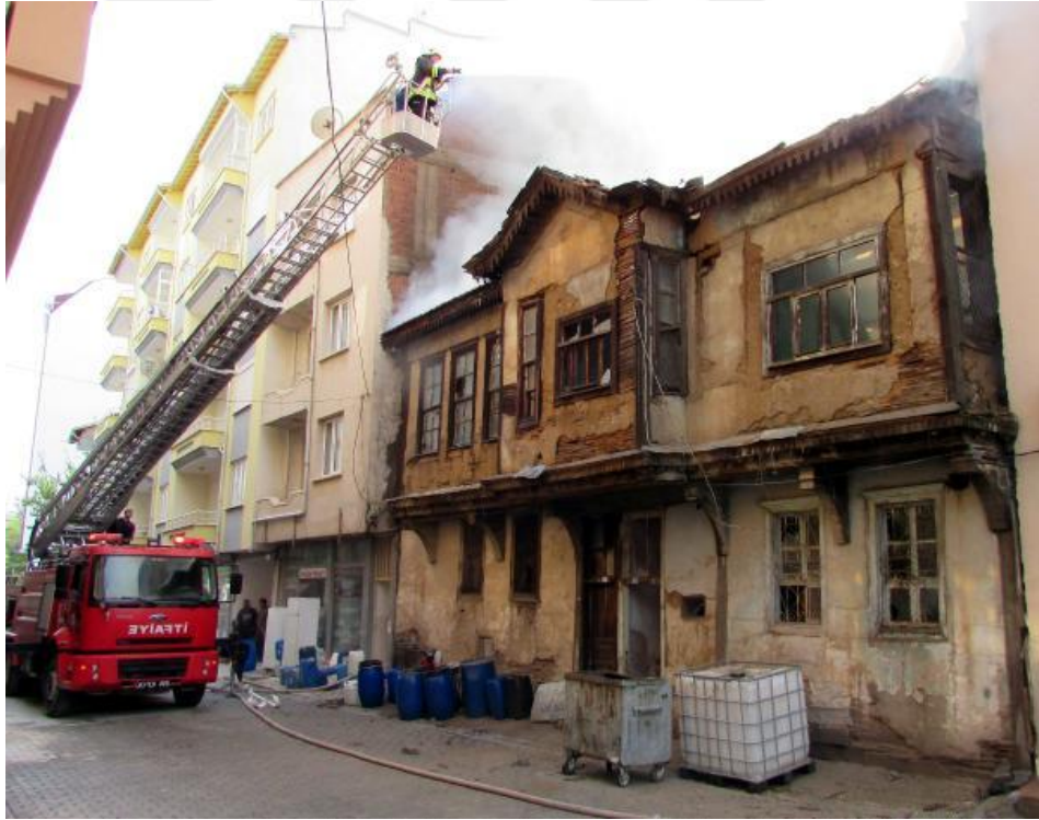
Şekil 4.44: Ahşap binanın yangın sonrası görünümü-2018
