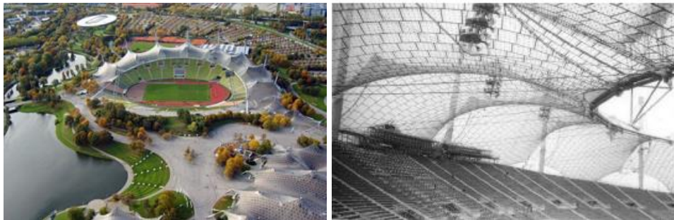
Şekil 3.21: Kablo ağı sistemlerin çatıda birleşimi Münih-Almanya
