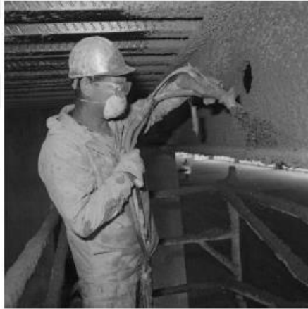
Şekil 4.22: Çelik kirişe koruma katmanının (Vermikülit ve çimento karışımı) püskürtülerek uygulanması
