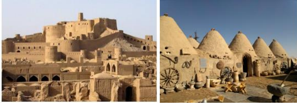
Şekil 3.51: Kerpiç yapı örnekleri – Harran
