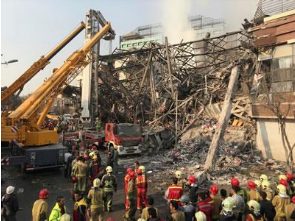
Şekil 4.1: Çelik Plasco binasının çöküşü – Tarhan 2017
