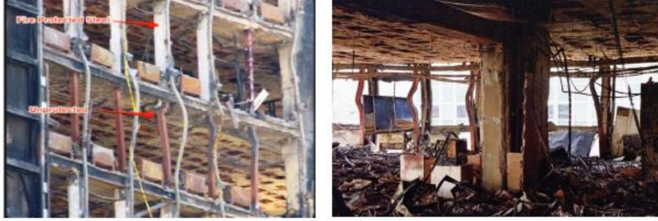
Şekil 4.8: Korumasız çelik kolonların yangın anında burkulması
