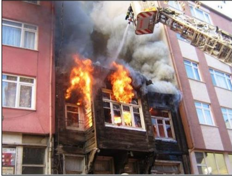
Şekil 4.42: Beyoğlu'nda tarihi ahşap binanın 2009' da elektrik akımı ile yanması
