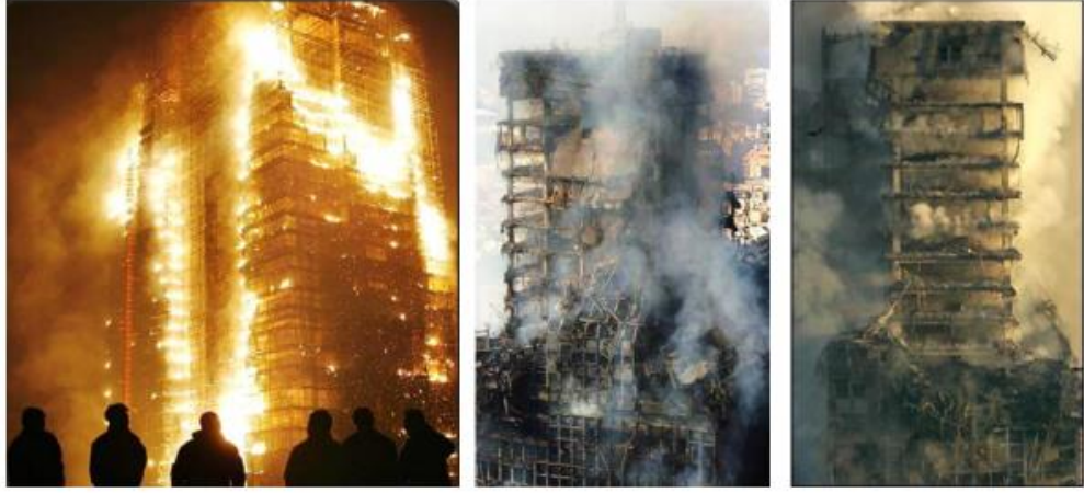
Şekil 4.2: Yangın anında meydana gelen çöküşler
