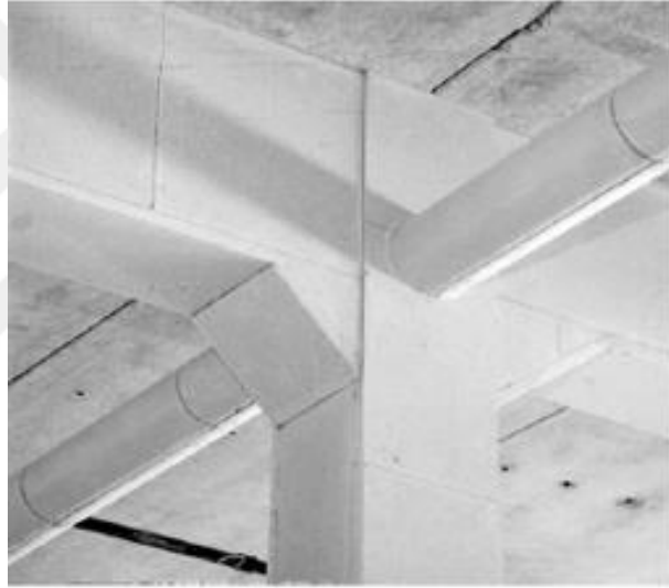
Şekil 4.27: Levhalarla korunan çelik yapı elemanları
