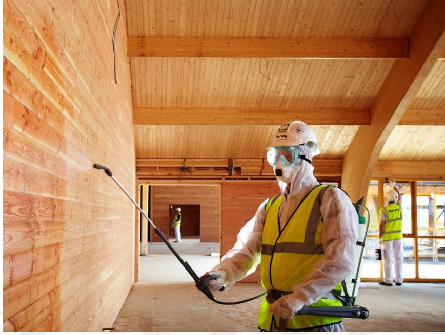
Şekil 4.51: Farklı ahşap türlerinin emprenye sıvılarıyla kaplanarak basınç yöntemiyle yangına dayanımının sağlanması
